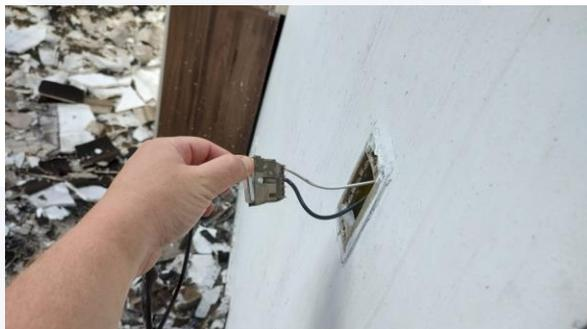
FOTO 2: cabeamento elétrico danificados
