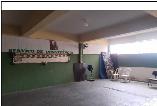
FOTO 31: PREDIO DO CENTRO DE CONVIVENCIA URBANO
