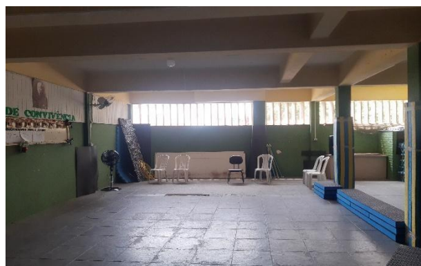
FOTO 32: PREDIO DO CENTRO DE CONVIVENCIA URBANO
