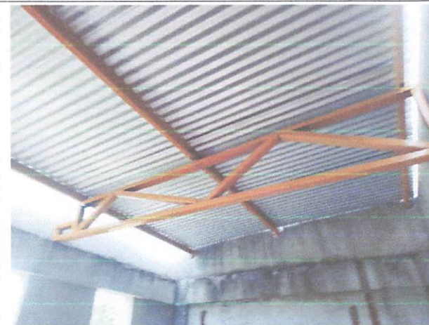
FOTO 11: Cobertura dos Vestiários
