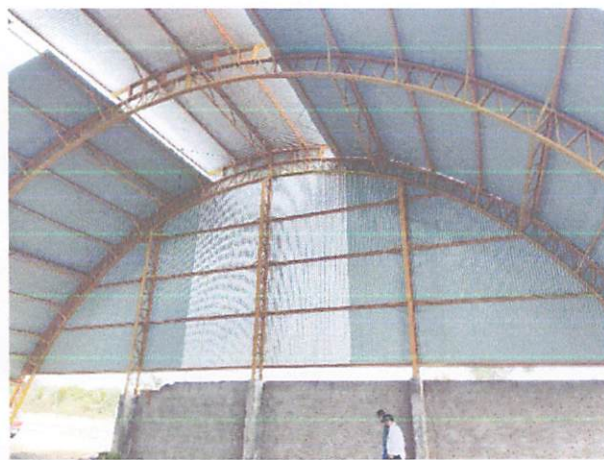
FOTO 8: Fechamento com telhas nos arcos
