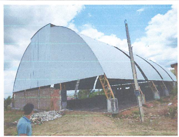
FOTO 4: Fechamento com telhas LD
