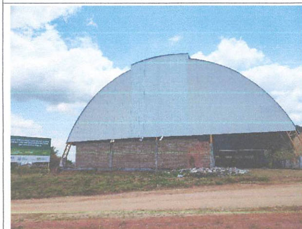
FOTO 5: Fechamento com telhas frontal
