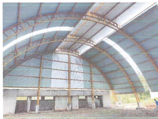
FOTO 9: Fechamento com telhas nos arcos
