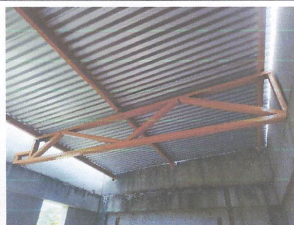
FOTO 12: Cobertura dos Vestiários
