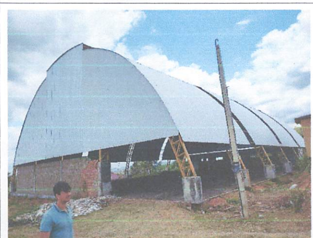
FOTO 6: Fechamento com telhas LD
