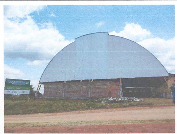
FOTO 2: Fechamento com telhas frontal
