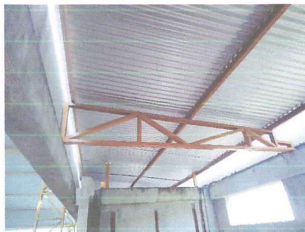
FOTO 10: Cobertura dos Vestiários
