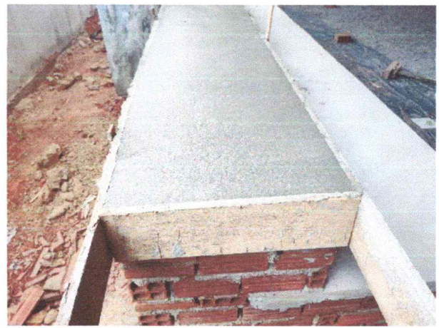
FOTO 14: Piso das arquibancadas
