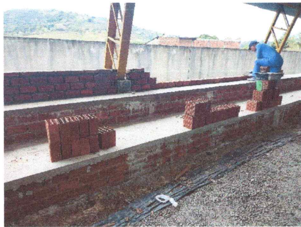
FOTO 15: Piso das arquibancadas
