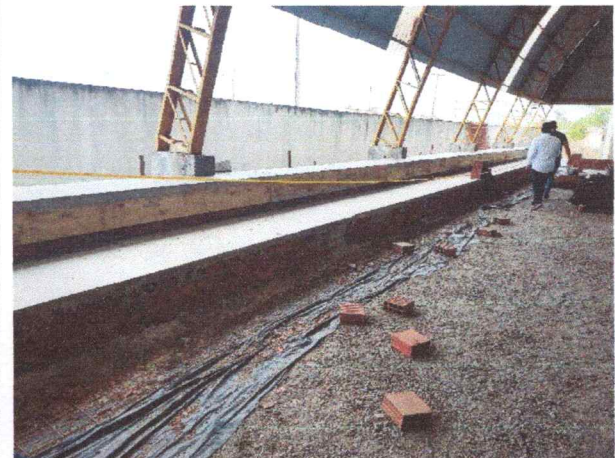
FOTO 18: Vista da Arquibancada
