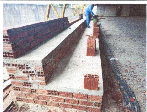
FOTO 12: Vista da Arquibancada
