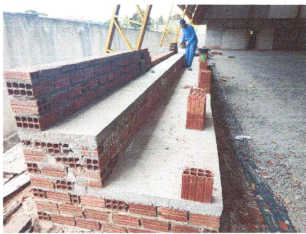
FOTO 13: Vista da Arquibancada
