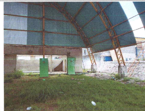
FOTO 11: Fechamento com telhas nos arcos
