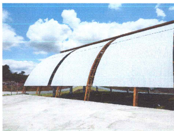
FOTO 4: Fechamento com telhas LD
