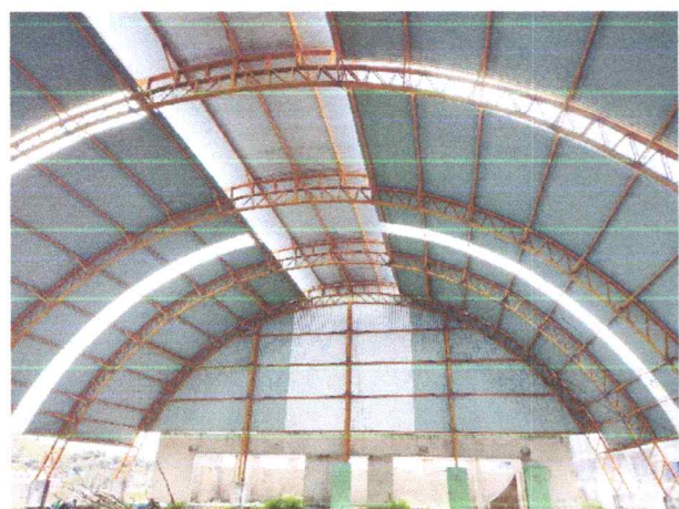
FOTO 9: Fechamento com telhas nos arcos
