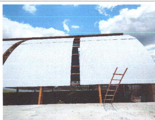
FOTO 6: Fechamento com telhas LD
