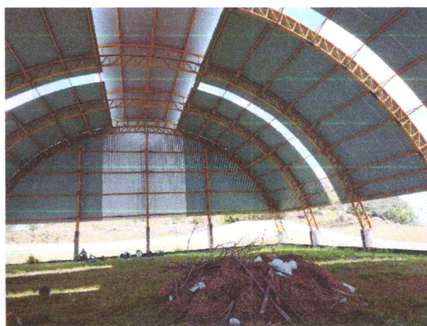
FOTO 8: Fechamento com telhas nos arcos
