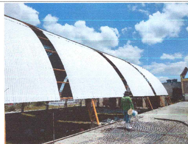
FOTO 5: Fechamento com telhas LD
