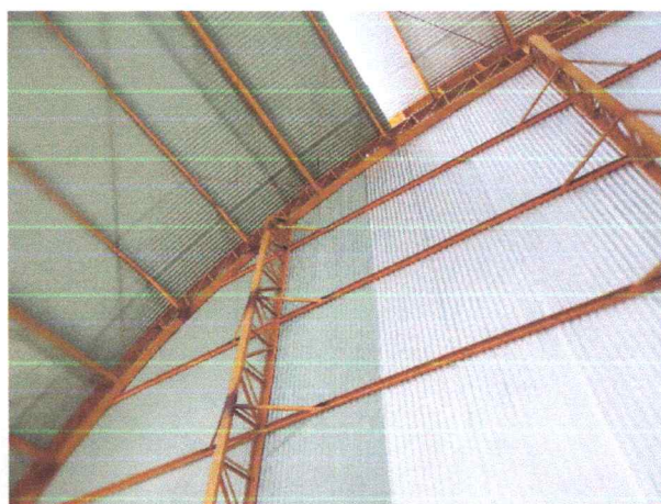
FOTO 10: Fechamento com telhas nos arcos
