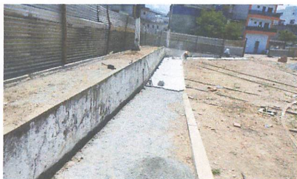
FOTO 2: Execução de passeio em piso intertravado
