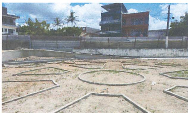
FOTO 3: Assentamento de guia (meio-fio) em trecho curvo
