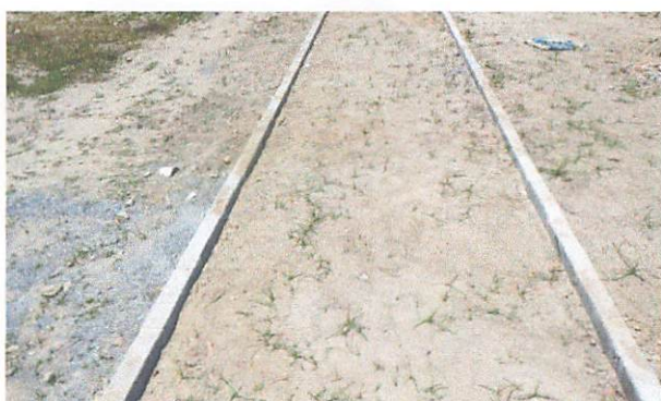
FOTO 4: Assentamento de guia (meio-fio) em trecho reto
