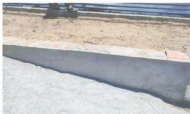
FOTO 10: Reaterro manual apilado com soquete
