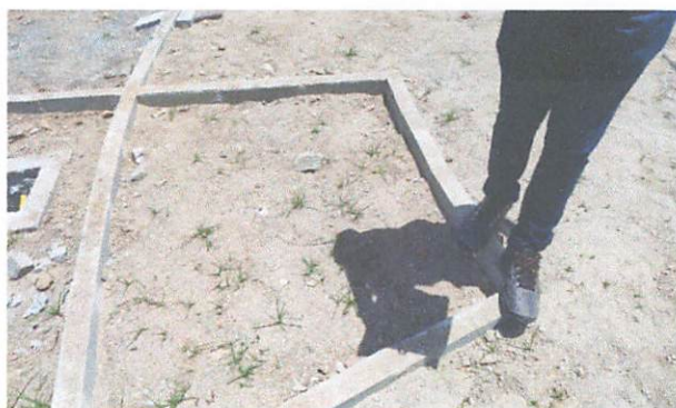
FOTO 9: Assentamento de guia (meio-fio) em trecho curvo
