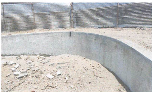
FOTO 5: Emboço ou massa única em argamassa traço 1:2:8
