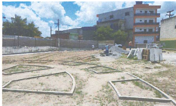
FOTO 12: Assentamento de guia (meio-fio) em trecho curvo
