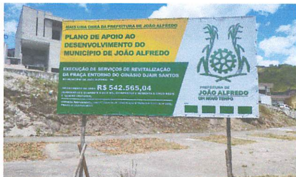
FOTO 1: Placa de obra em chapa aço galvanizado
