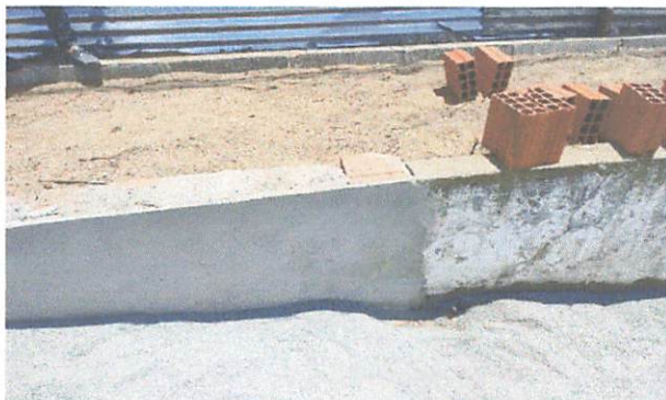
FOTO 7: Alvenaria em tijolo cerâmico furado 9x9x19cm
