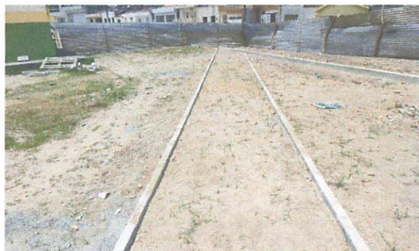
FOTO 8: Assentamento de guia (meio-fio) em trecho reto
