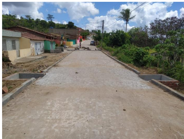
FOTO 2: Pavimentação em paral. Graníticos - Rua 01
