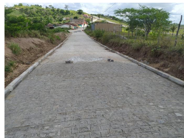
FOTO 5: Pavimentação em paral. Graníticos - Rua 01
