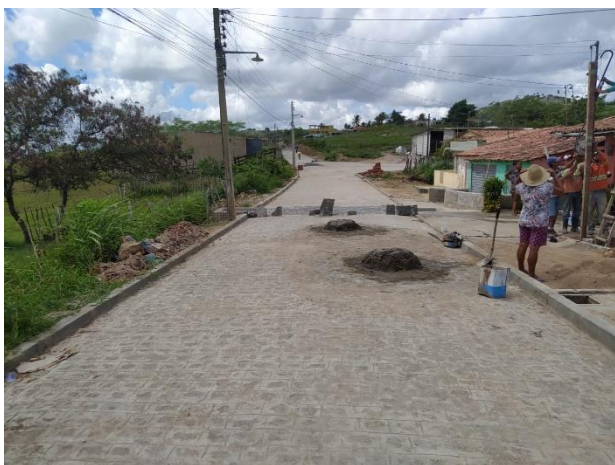
FOTO 1: Pavimentação em paral. Graníticos - Rua 01
