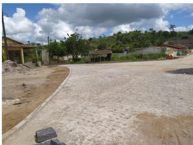
FOTO 3: Escoramento de MF com material do local - Rua 01
