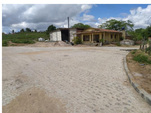
FOTO 4: Pavimentação em paral. Graníticos - Rua 01
