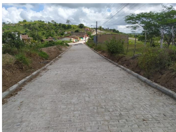
FOTO 6: Pavimentação em paral. Graníticos - Rua 01
