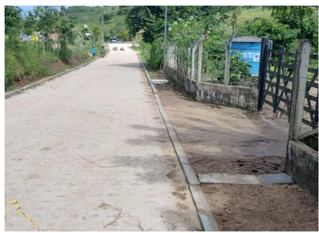
FOTO 4: Pavimentação em paral. Graníticos - Rua 01
