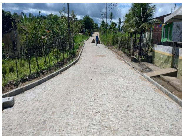
FOTO 1: Pavimentação em paral. Graníticos - Rua 01
