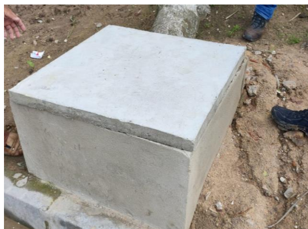
FOTO 5: Caixa enterrada hidráulica retangular em alvenaria - Rua 01
