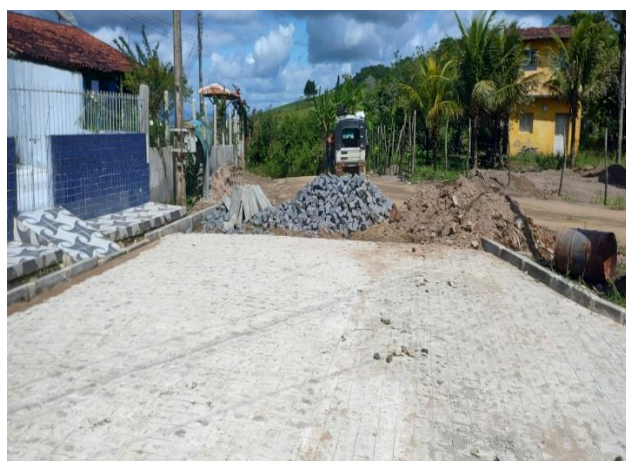
FOTO 2: Pavimentação em paral. Graníticos - Rua 01
