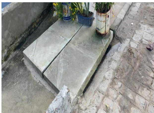
FOTO 7: Caixa enterrada hidráulica retangular em alvenaria - Rua 01
