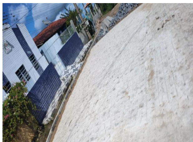
FOTO 3: Pavimentação em paral. Graníticos - Rua 01
