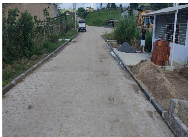
FOTO 8: Caixa enterrada hidráulica retangular em alvenaria - Rua 01
