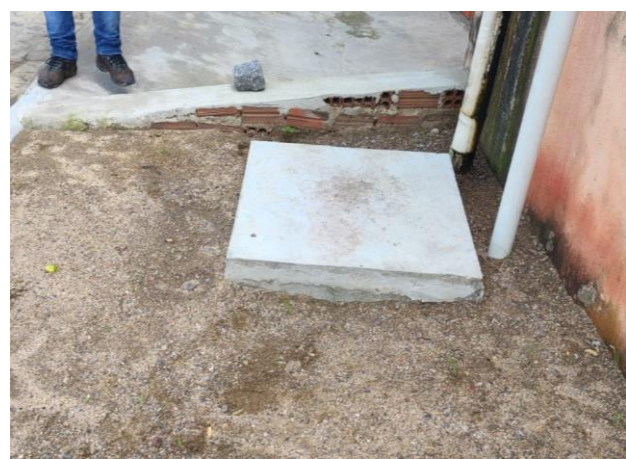
FOTO 6: Caixa enterrada hidráulica retangular em alvenaria - Rua 01
