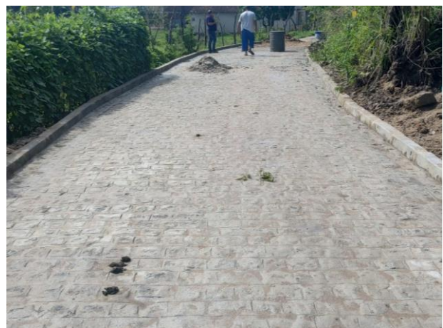
FOTO 5: Pavimentação em paral. Graníticos - Rua 01 / trecho 02
