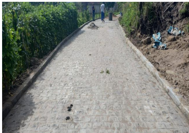
FOTO 2: Pavimentação em paral. Graníticos - Rua 01 / trecho 02
