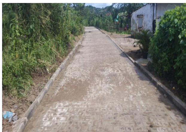
FOTO 3: Pavimentação em paral. Graníticos - Rua 01 / trecho 02
