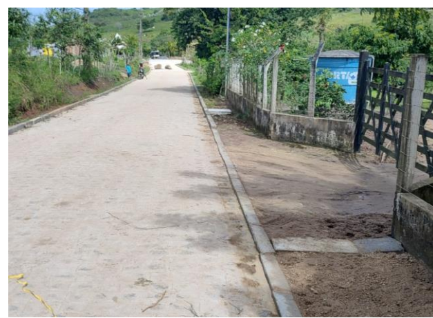
FOTO 6: Caixa enterrada hidráulica retangular em alvenaria - Rua 01
