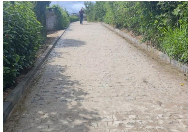
FOTO 4: Pavimentação em paral. Graníticos - Rua 01 / trecho 02
