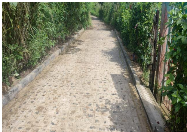
FOTO 1: Pavimentação em paral. Graníticos - Rua 01 / trecho 02
