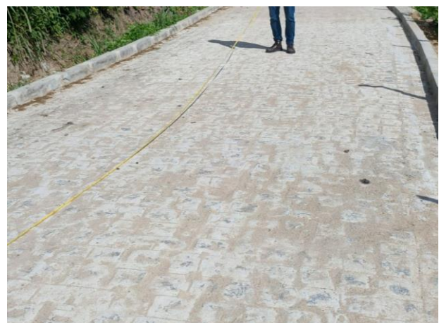
FOTO 5: Pavimentação em paral. Graníticos - Rua 01 / trecho 02
