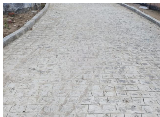
FOTO 6: Pavimentação em paral. Graníticos - Rua 01 / trecho 02
