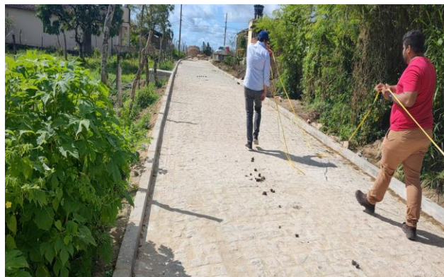
FOTO 2: Pavimentação em paral. Graníticos - Rua 01 / trecho 02
