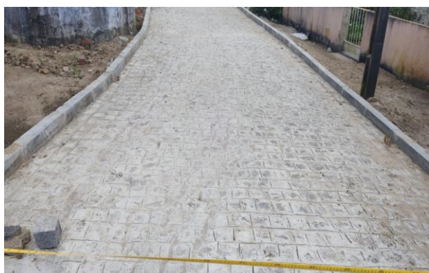
FOTO 3: Pavimentação em paral. Graníticos - Rua 01 / trecho 02
