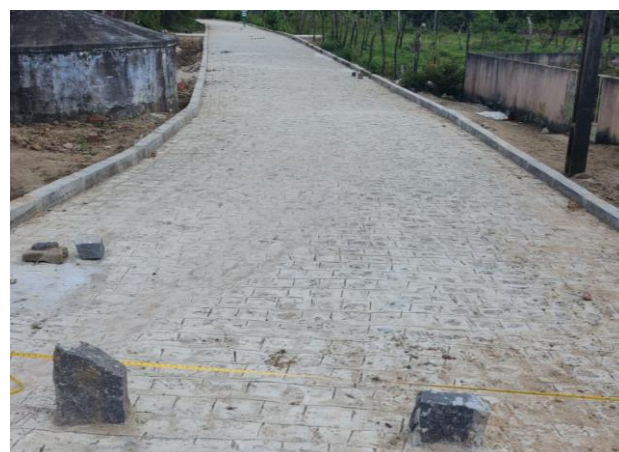
FOTO 4: Pavimentação em paral. Graníticos - Rua 01 / trecho 02
