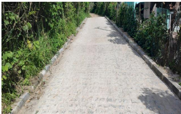
FOTO 1: Pavimentação em paral. Graníticos - Rua 01 / trecho 02
