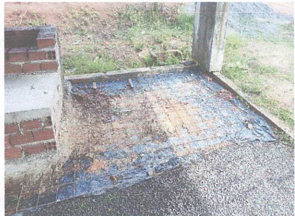
FOTO 4: Malha, lona e piso em concreto 7cm
