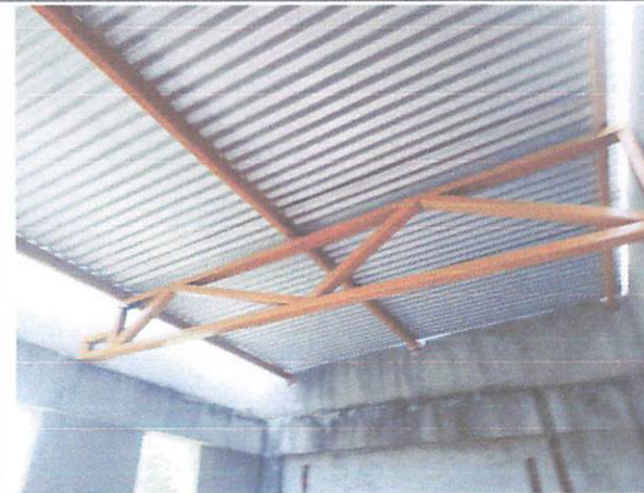
FOTO 11: Cobertura dos Vestiários
