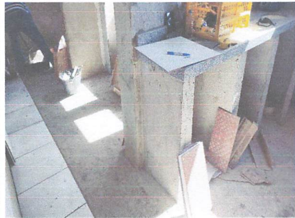
FOTO 9: Bancada dos Vestiários
