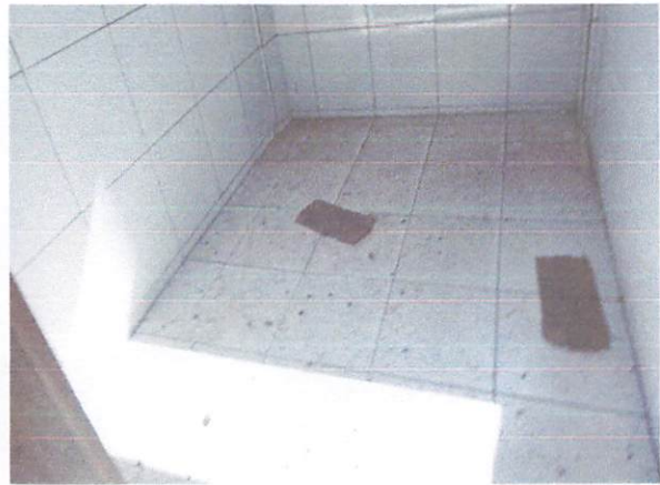
FOTO 10: Revestimento cerâmico em piso
