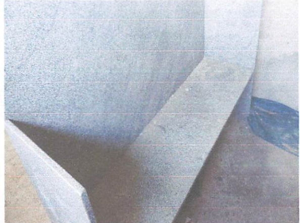
FOTO 8: Bancada dos Vestiários
