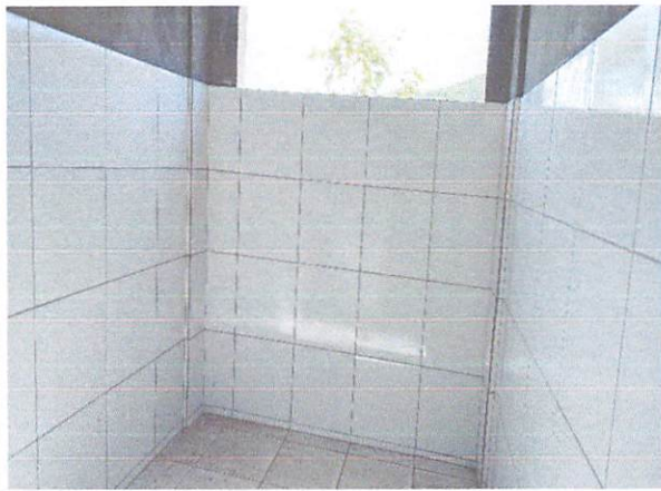
FOTO 7: Revestimento cerâmico em paredes
