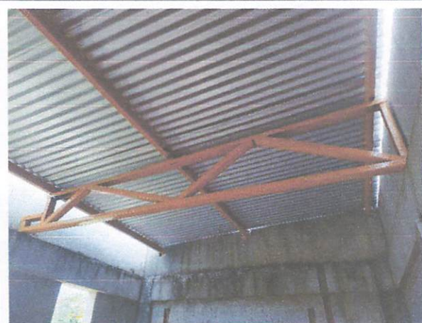
FOTO 12: Cobertura dos Vestiários
