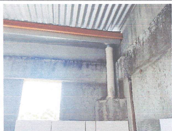
FOTO 6: Calha dos Vestiários
