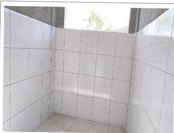
FOTO 7: Revestimento cerâmico em paredes
