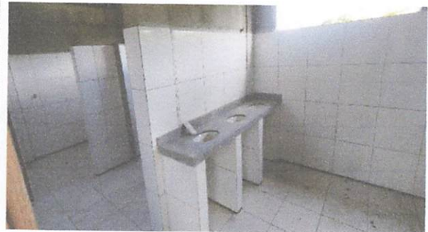
FOTO 4: Revestimento cerâmico em paredes e piso
