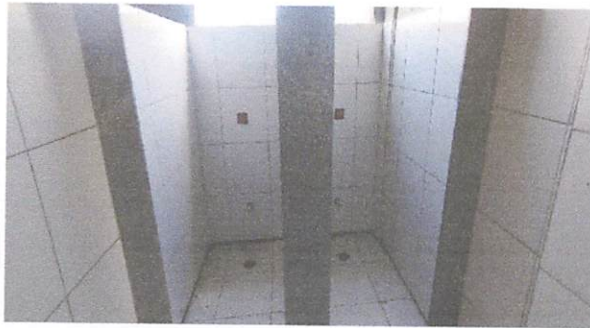
FOTO 1: Divisórias dos Vestiários
