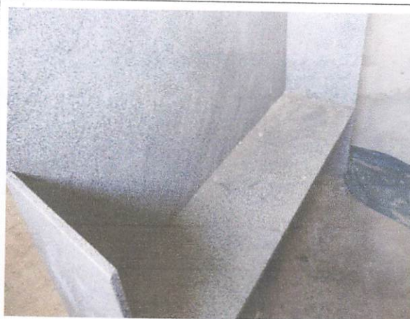
FOTO 8: Bancada dos Vestiários
