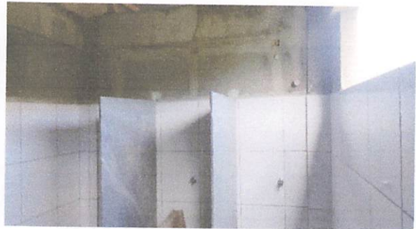
FOTO 2: Divisórias dos Vestiários
