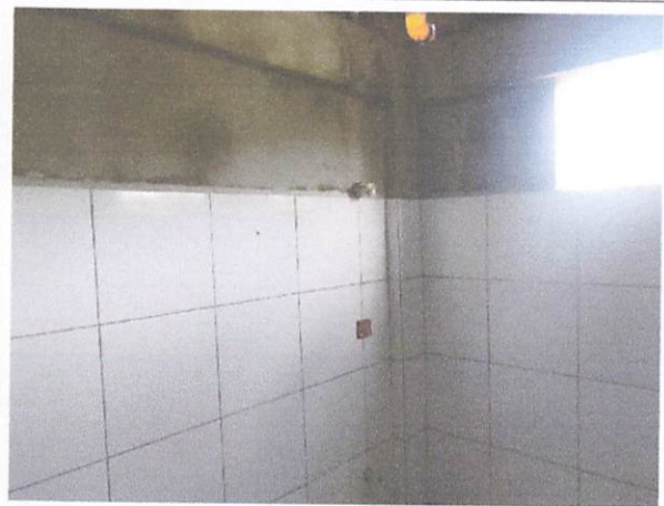
FOTO 6: Válvulas de descargas
