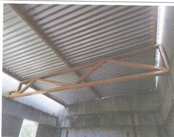
FOTO 12: Cobertura dos Vestiários
