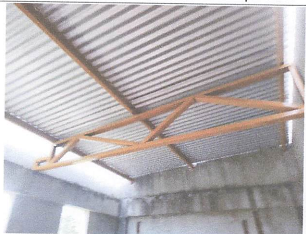
FOTO 11: Cobertura dos Vestiários
