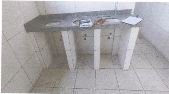
FOTO 3: Revestimento cerâmico em paredes e piso
