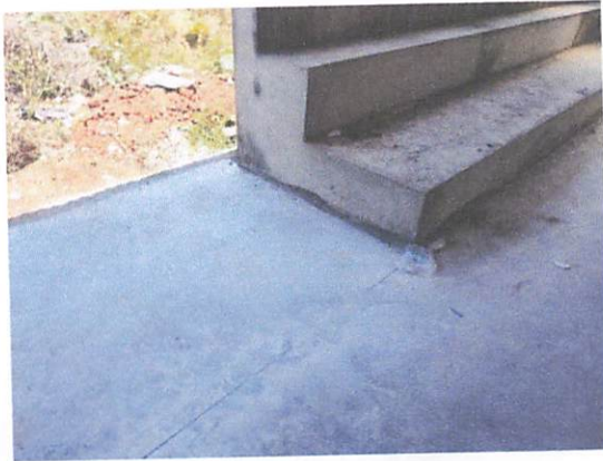
FOTO 3: Concretagem do piso da área de jogos
