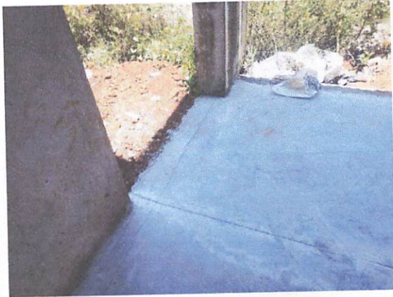
FOTO 1: Concretagem do piso da área de jogos
