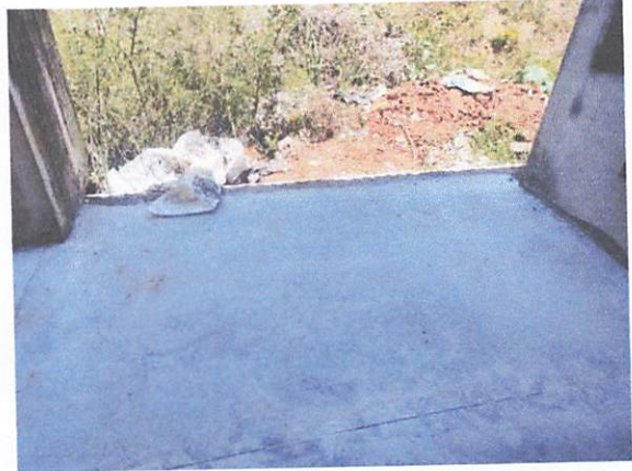
FOTO 2: Concretagem do piso da área de jogos
