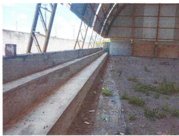
FOTO 4: Revestimento das Arquibancadas
