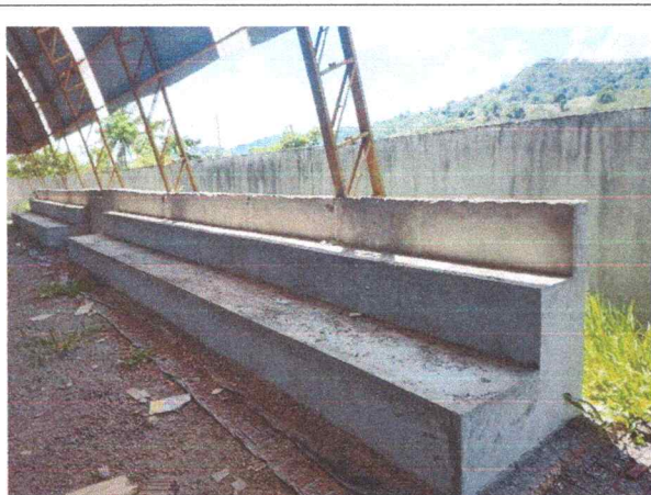
FOTO 1: Revestimento das Arquibancadas
