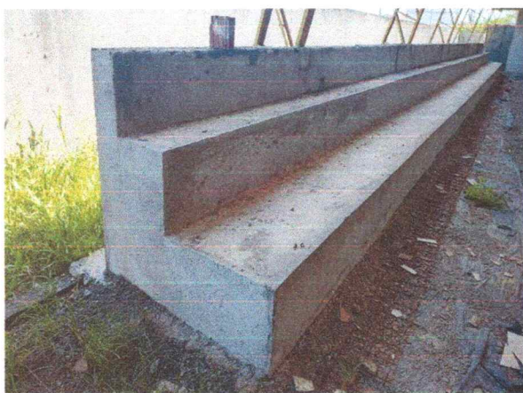
FOTO 3: Revestimento das Arquibancadas
