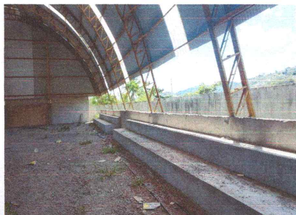
FOTO 2: Revestimento das Arquibancadas
