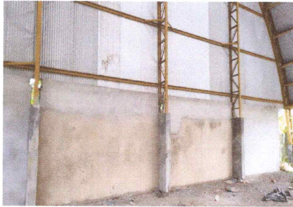
FOTO 1: Revestimento externo (Chapisco e Reboco)
