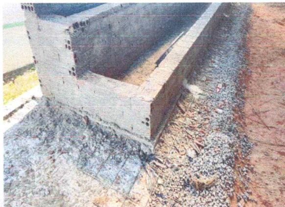
FOTO 2: Brita, lona, malha e piso em concreto 7cm
