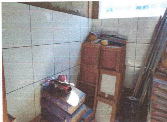
FOTO 8: Revestimento cerâmico em paredes
