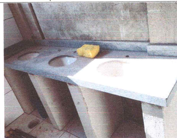
FOTO 5: Bancada em granito
