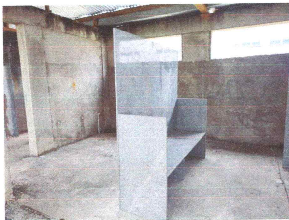
FOTO 9: Calha dos vestiários
