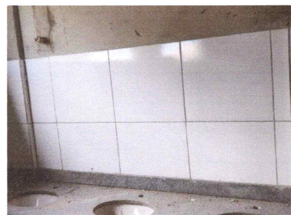
FOTO 5: Revestimento cerâmico em paredes
