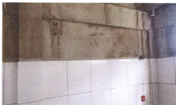
FOTO 8: Revestimento cerâmico em paredes
