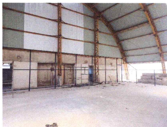
FOTO 2: Alambrado e concretagem do piso
