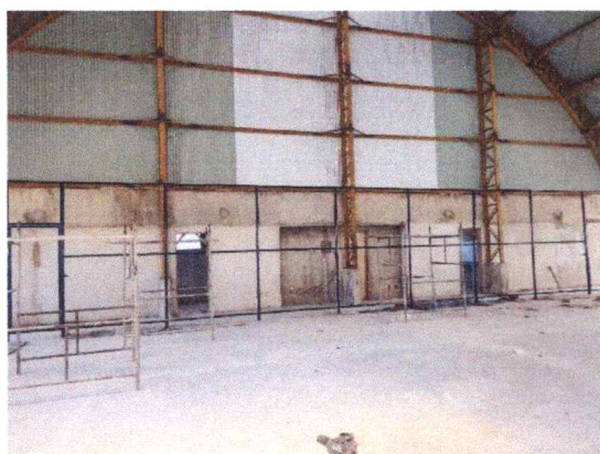
FOTO 3: Alambrado e concretagem do piso
