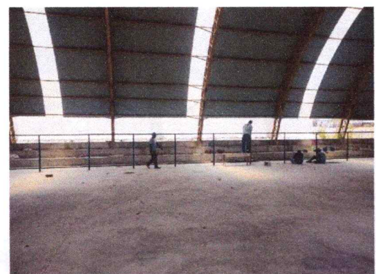
FOTO 5: Alambrado e concretagem do piso
