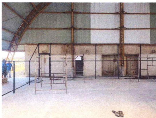
FOTO 1: Alambrado e concretagem do piso
