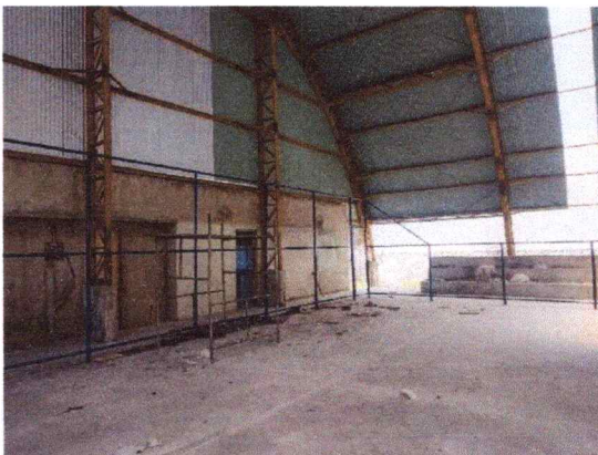
FOTO 4: Alambrado e concretagem do piso
