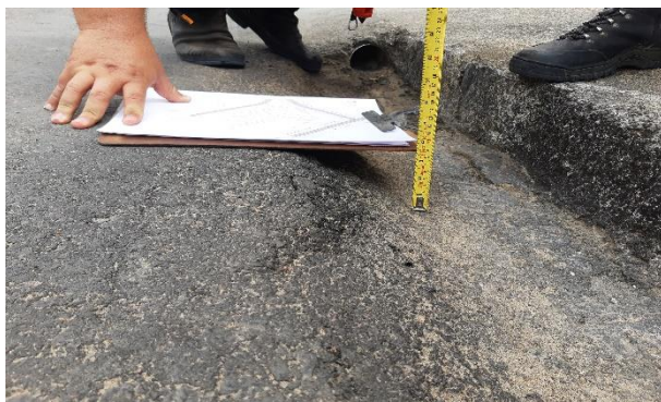
FOTO 11: Espessura do asfalto
