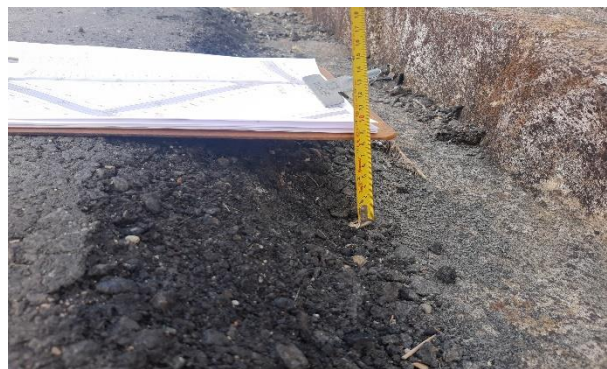
FOTO 12: Espessura do asfalto
