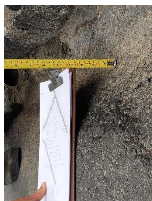
FOTO 10: Espessura do asfalto
