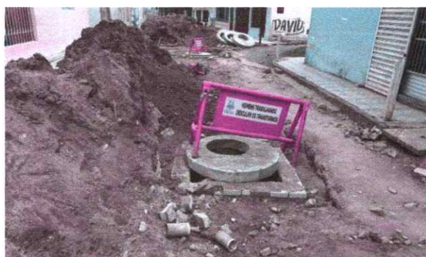
FOTO 3: Demolição de pavimentação rua Santa Rita de Cássia.
