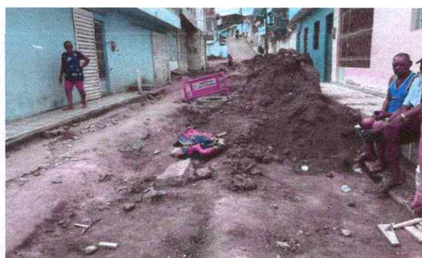
FOTO 4: Demolição de pavimentação rua Santa Rita de Cássia.
