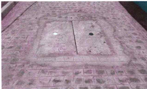
FOTO 9: Execução de Caixa hidráulica.
