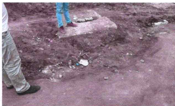
FOTO 2: Demolição de pavimentação rua Santa Rita de Cássia.
