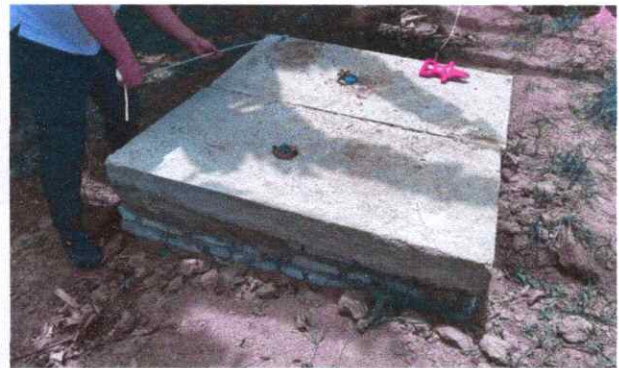
FOTO 8: Execução de Caixa hidráulica.
