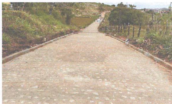
FOTO 8: Rua 01 – Pavimentação em paralelepípedos
