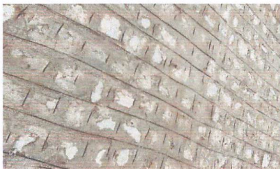
FOTO 7: Rua 01 – Pavimentação em paralelepípedos, trecho do Muro de contenção
