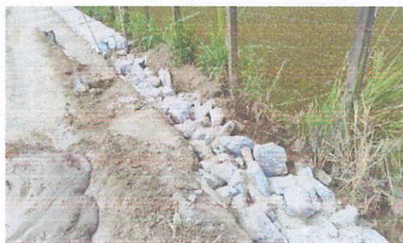
FOTO 3: Rua 01 – Base Muro de Contenção
