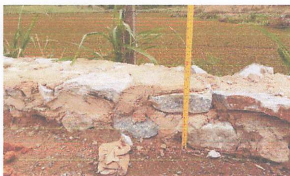
FOTO 4: Rua 01 – Elevação Muro de Contenção
