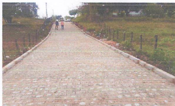
FOTO 5: Rua 01 – Pavimentação em paralelepípedos
