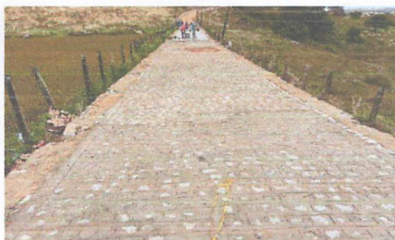
FOTO 6: Rua 01 – Pavimentação em paralelepípedos, trecho do Muro de contenção
