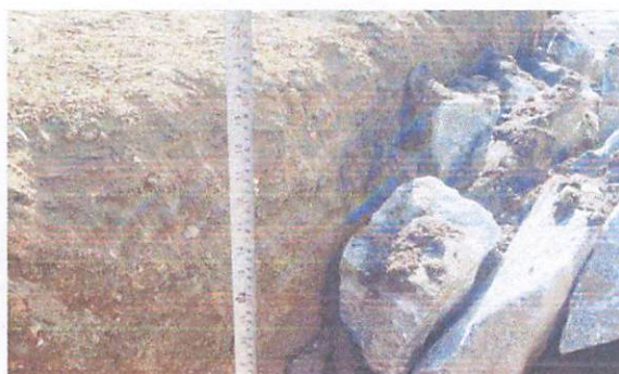
FOTO 2: Rua 01 – Escavação Muro de Contenção
