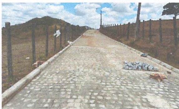
FOTO 9: Rua 01 – Pavimentação em paralelepípedos
