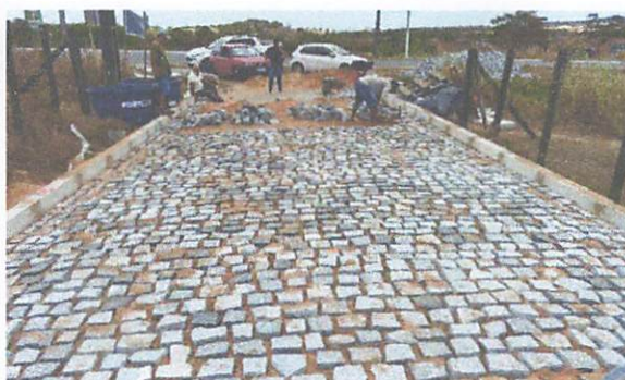
FOTO 11: Rua 01 – Pavimentação em paralelepípedos
