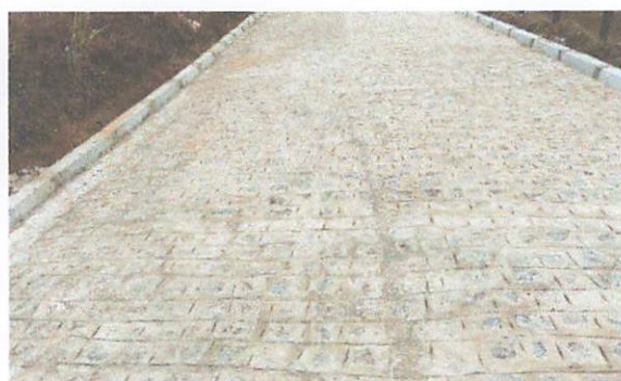
FOTO 4: Rua 01 – Pavimentação em paralelepípedos
