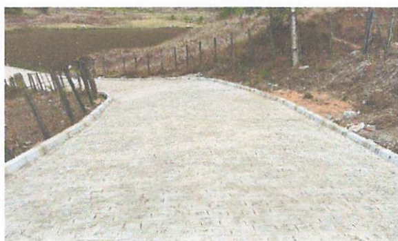
FOTO 1: Rua 01 – Pavimentação em paralelepípedos
