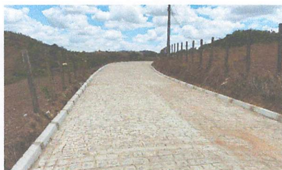
FOTO 5: Rua 01 – Pavimentação em paralelepípedos
