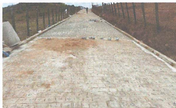
FOTO 10: Rua 01 – Pavimentação em paralelepípedos
