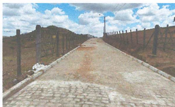
FOTO 12: Rua 01 – Pavimentação em paralelepípedos
