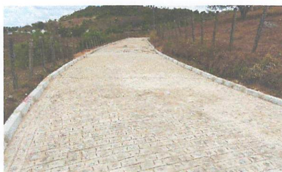
FOTO 3: Rua 01 – Pavimentação em paralelepípedos
