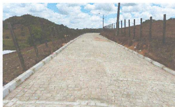
FOTO 6: Rua 01 – Pavimentação em paralelepípedos
