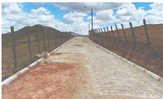
FOTO 7: Rua 01 – Pavimentação em paralelepípedos
