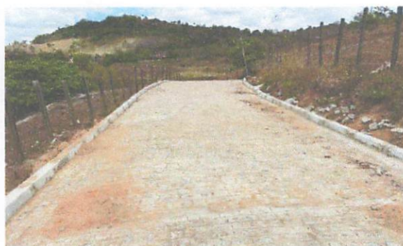
FOTO 2: Rua 01 – Pavimentação em paralelepípedos
