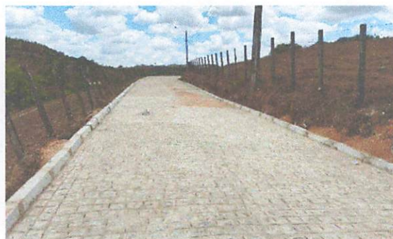
FOTO 8: Rua 01 – Pavimentação em paralelepípedos
