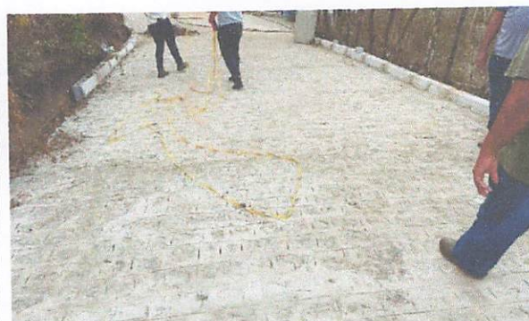
FOTO 10: Rua 02 – Pavimentação em paralelepípedos
