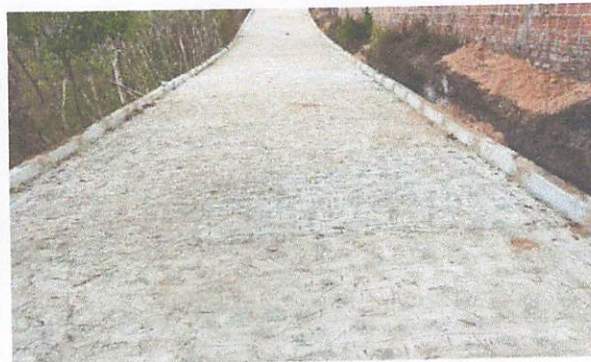
FOTO 8: Rua 02 – Pavimentação em paralelepípedos
