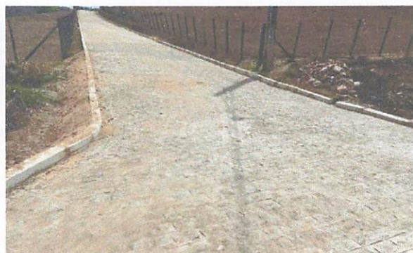
FOTO 2: Rua 01 – Pavimentação em paralelepípedos
