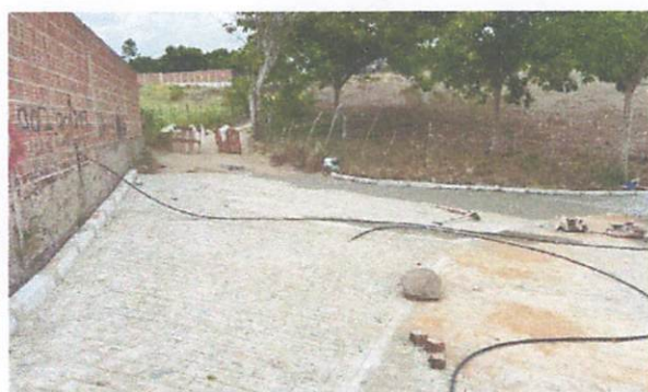
FOTO 11: Rua 02 – Pavimentação em paralelepípedos
