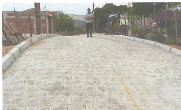
FOTO 4: Rua 02 – Pavimentação em paralelepípedos
