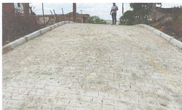
FOTO 3: Rua 02 – Pavimentação em paralelepípedos
