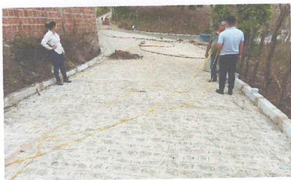
FOTO 7: Rua 02 – Pavimentação em paralelepípedos
