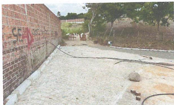
FOTO 9: Rua 02 – Pavimentação em paralelepípedos
