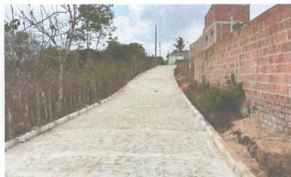
FOTO 6: Rua 02 – Pavimentação em paralelepípedos
