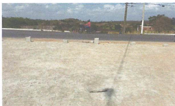
FOTO 1: Rua 01 – Pavimentação em paralelepípedos
