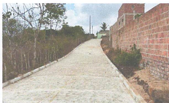
FOTO 6: Rua 02 – Pavimentação em paralelepípedos
