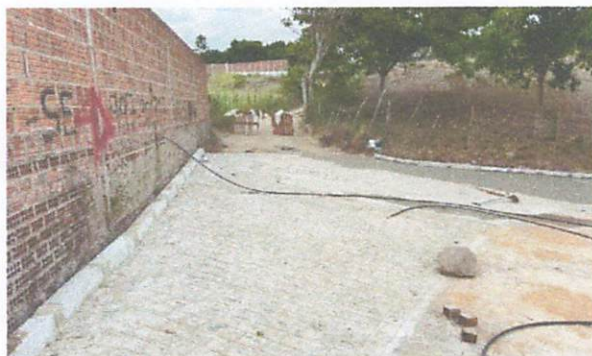
FOTO 9: Rua 02 – Pavimentação em paralelepípedos
