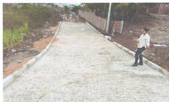
FOTO 5: Rua 02 – Pavimentação em paralelepípedos
