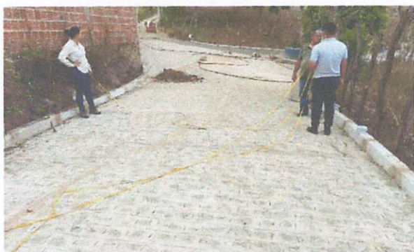
FOTO 7: Rua 02 – Pavimentação em paralelepípedos
