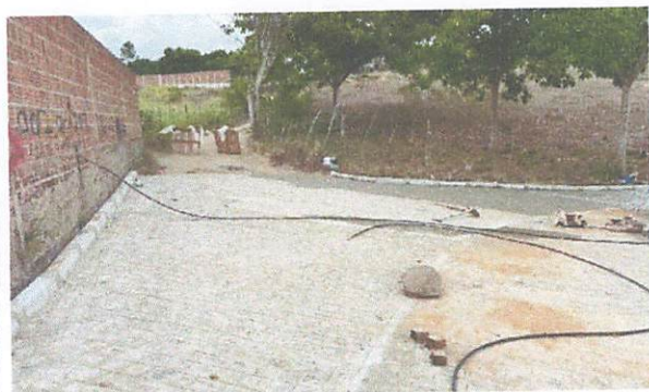
FOTO 11: Rua 02 – Pavimentação em paralelepípedos
