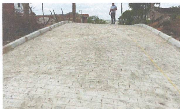
FOTO 3: Rua 02 – Pavimentação em paralelepípedos
