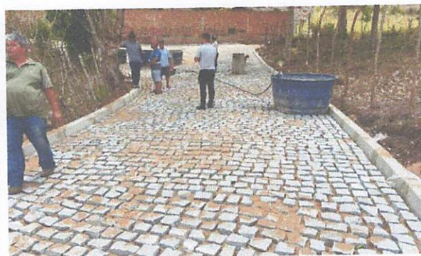
FOTO 12: Rua 02 – Pavimentação em paralelepípedos
