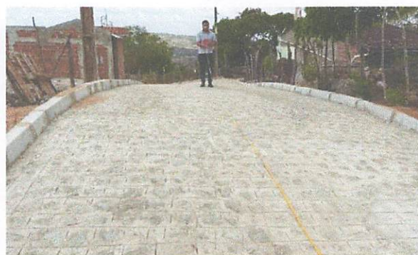
FOTO 4: Rua 02 – Pavimentação em paralelepípedos
