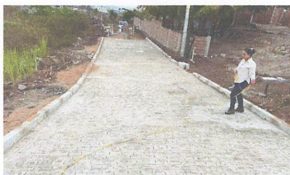
FOTO 5: Rua 02 – Pavimentação em paralelepípedos
