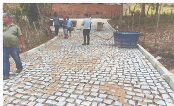
FOTO 12: Rua 02 – Pavimentação em paralelepípedos
