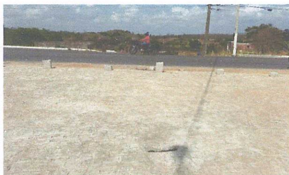
FOTO 1: Rua 01 – Pavimentação em paralelepípedos
