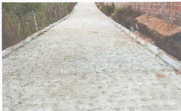
FOTO 8: Rua 02 – Pavimentação em paralelepípedos
