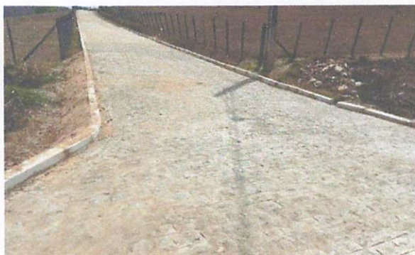
FOTO 2: Rua 01 – Pavimentação em paralelepípedos
