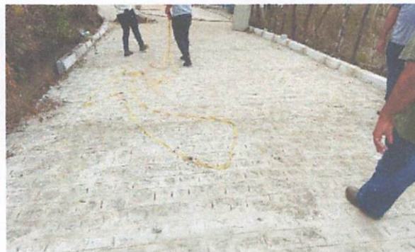
FOTO 10: Rua 02 – Pavimentação em paralelepípedos
