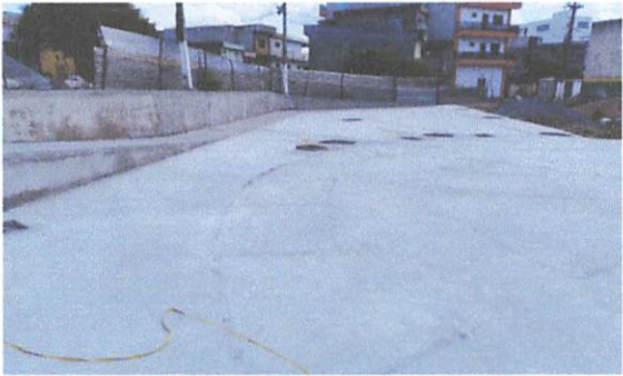
FOTO 9: Piso em concreto 20 mpa
