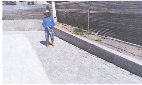
FOTO 8: Execução de passeio em piso intertravado
