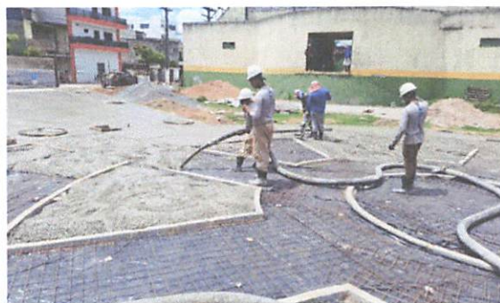
FOTO 5: Piso em concreto 20 mpa
