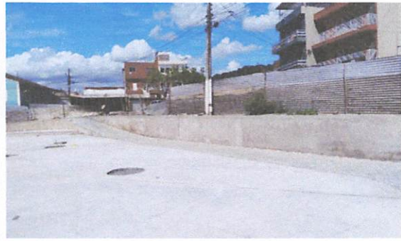
FOTO 12: Piso em concreto 20 mpa
