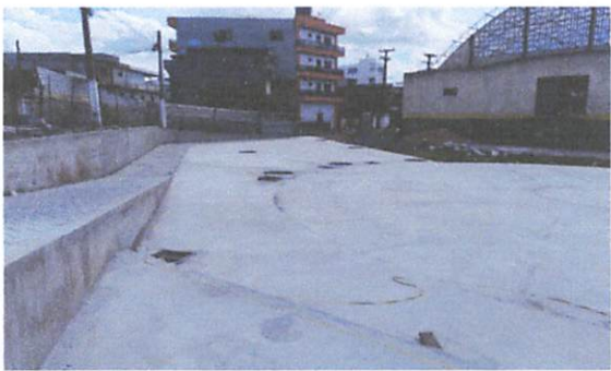
FOTO 11: Piso em concreto 20 mpa
