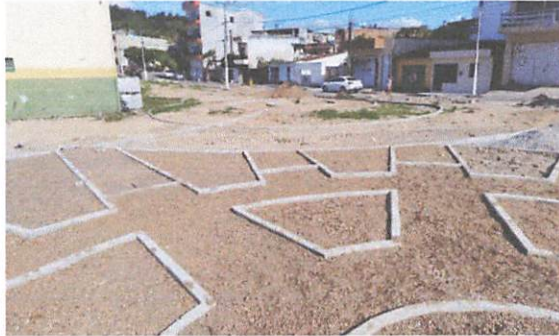
FOTO 1: Assentamento de guia (meio-fio) em trecho curvo
