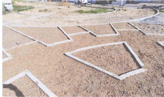
FOTO 2: Assentamento de guia (meio-fio) em trecho curvo
