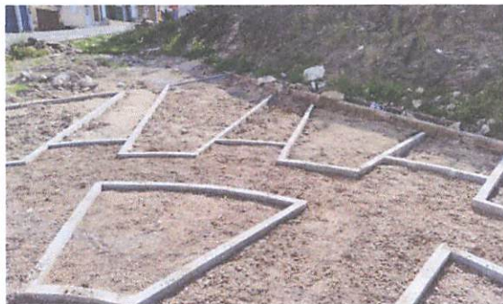
FOTO 3: Assentamento de guia (meio-fio) em trecho curvo
