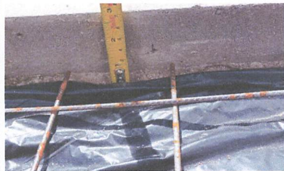
FOTO 6: Aplicação de lona plástica e tela aço soldada nervurada ca-60, q-138, malha 10x10cm
