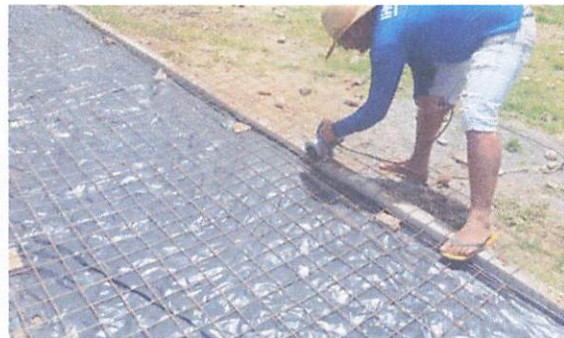
FOTO 4: Aplicação de lona plástica e tela aço soldada nervurada ca-60, q-138, malha 10x10cm
