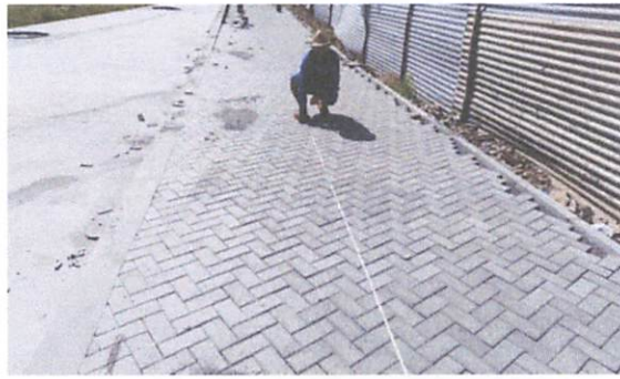
FOTO 7: Execução de passeio em piso intertravado
