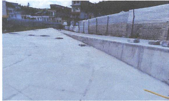
FOTO 10: Piso em concreto 20 mpa
