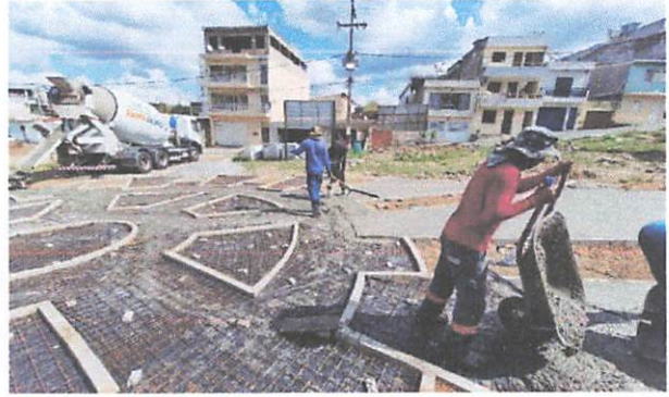
FOTO 2: Piso em concreto 20 mpa
