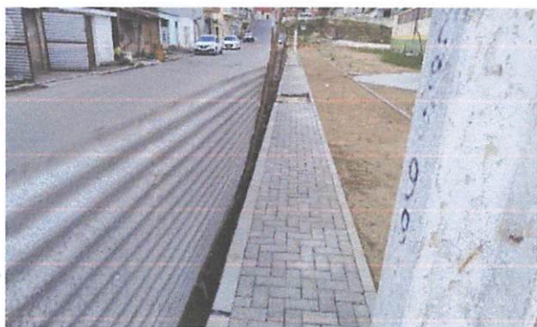
FOTO 5: Assentamento de guia (meio-fio) em trecho reto e execução de passeio em piso intertravado
