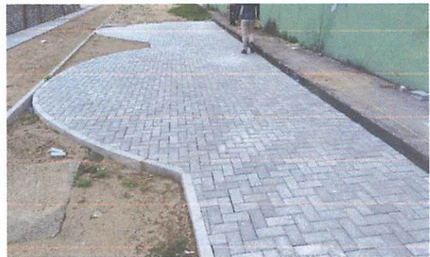
FOTO 4: Execução de passeio em piso intertravado
