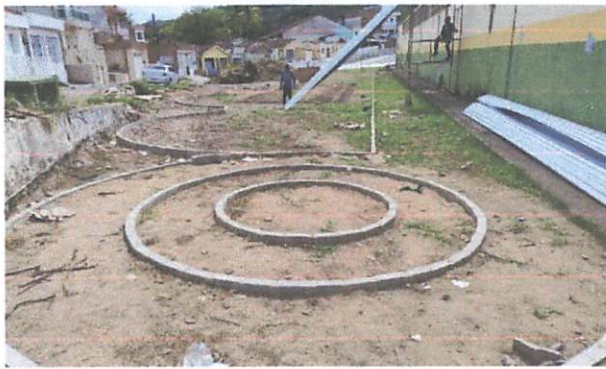
FOTO 7: Assentamento de guia (meio-fio) em trecho curvo
