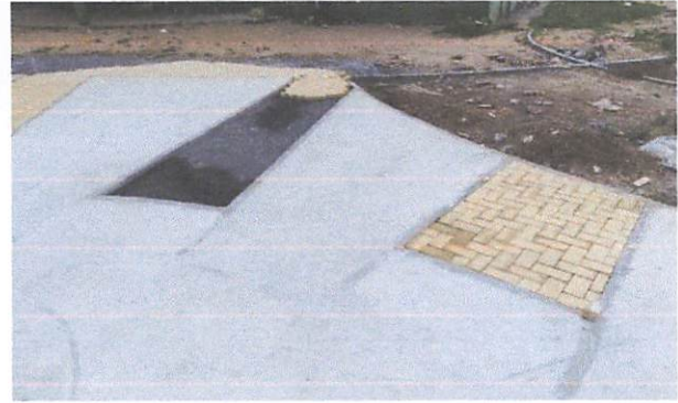
FOTO 10: Execução de passeio em piso intertravado, com bloco retangular colorido
