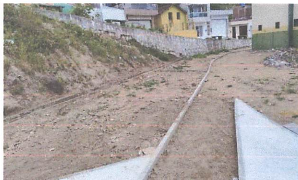
FOTO 11: Assentamento de guia (meio-fio) em trecho reto
