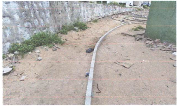
FOTO 8: Assentamento de guia (meio-fio) em trecho curvo
