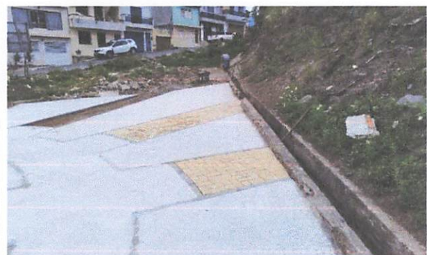
FOTO 6: Execução de passeio em piso intertravado, com bloco retangular colorido
