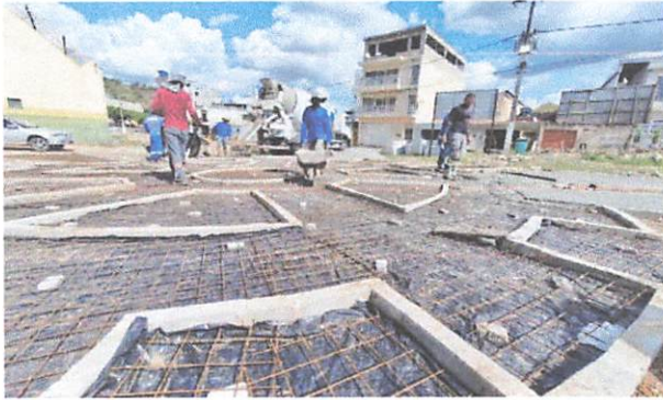
FOTO 1: Aplicação de lona plástica e instalação de tela de aço
