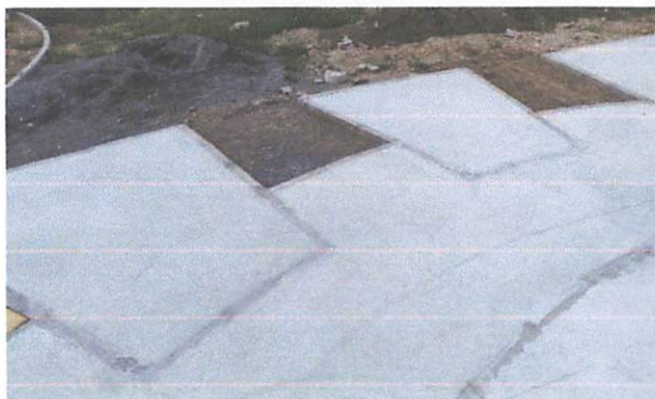
FOTO 3: Piso em concreto 20 mpa
