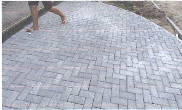
FOTO 9: Execução de passeio em piso intertravado
