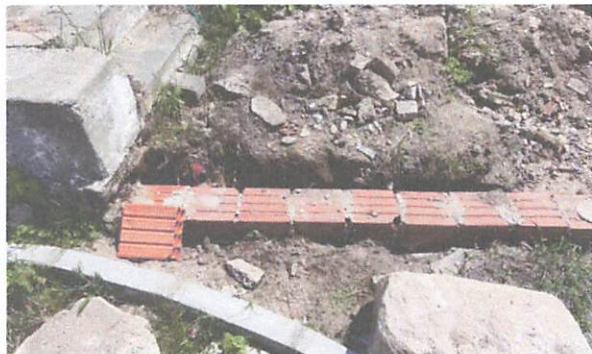
FOTO 7: Alvenaria em tijolo cerâmico 1 vez
