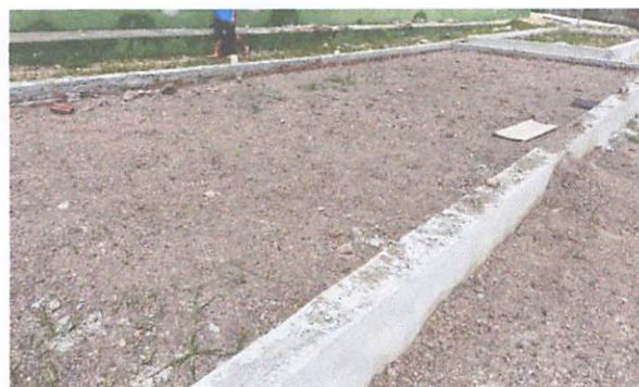
FOTO 10: Alvenaria em tijolo cerâmico 1 vez / Emboço
