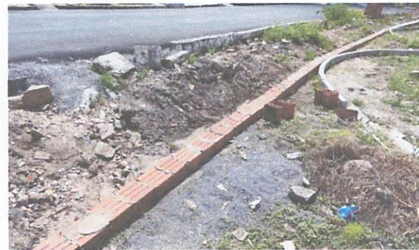
FOTO 6: Alvenaria em tijolo cerâmico 1 vez
