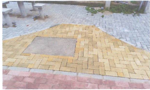
FOTO 2: Execução de passeio em piso intertravado, com bloco retangular amarelo
