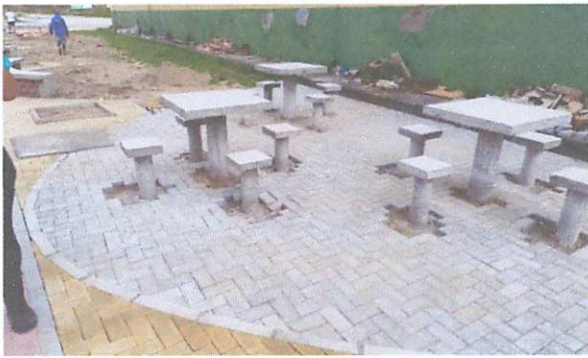
FOTO 1: Execução de passeio em piso intertravado, com bloco retangular amarelo
