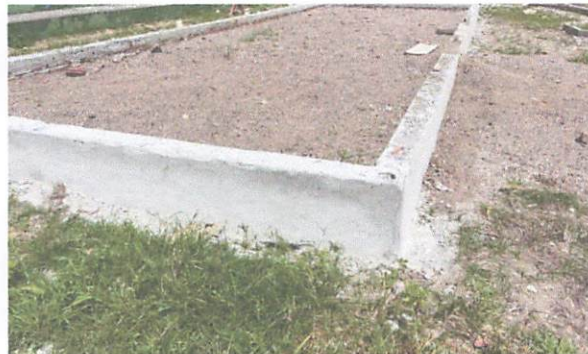
FOTO 8: Alvenaria em tijolo cerâmico 1 vez / Emboço
