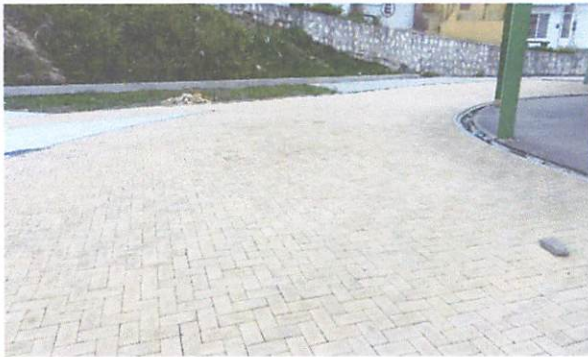
FOTO 3: Execução de passeio em piso intertravado, com bloco retangular amarelo
