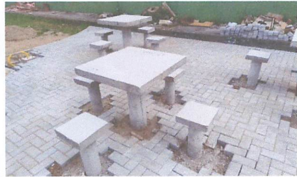
FOTO 4: Execução de passeio em piso intertravado, com bloco retangular natural
