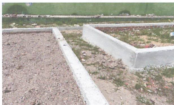
FOTO 9: Alvenaria em tijolo cerâmico 1 vez / Emboço
