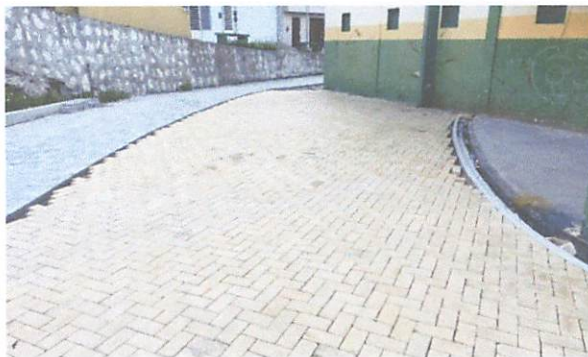
FOTO 5: Execução de passeio em piso intertravado, com bloco retangular amarelo
