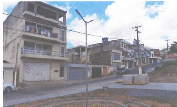
FOTO 12: Poste de iluminação 2 pétalas com luminárias 50w Led
