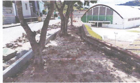
FOTO 16: Assentamento de guia meio fio e alvenaria de 1 vez
