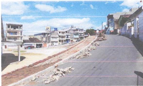
FOTO 15: Assentamento de guia meio fio e alvenaria de 1 vez
