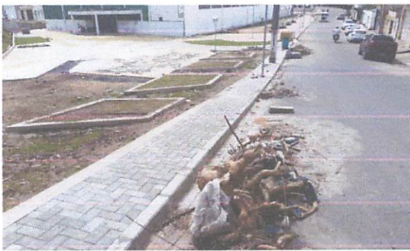
FOTO 13: Execução de passeio em piso intertravado de cor natural
