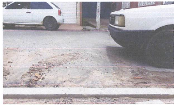
FOTO 14: Assentamento de guia meio-fio
