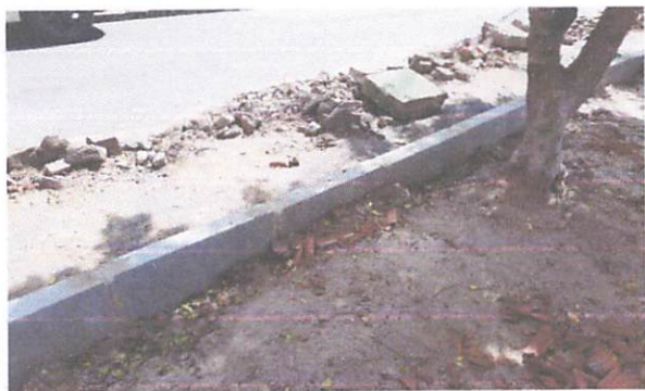
FOTO 7: Assentamento de guia meio-fio
