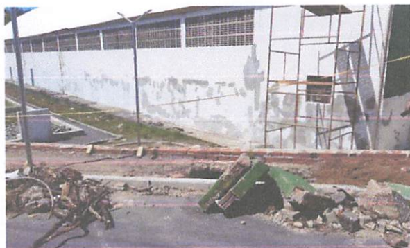
FOTO 9: Assentamento de guia meio fio e alvenaria de 1 vez
