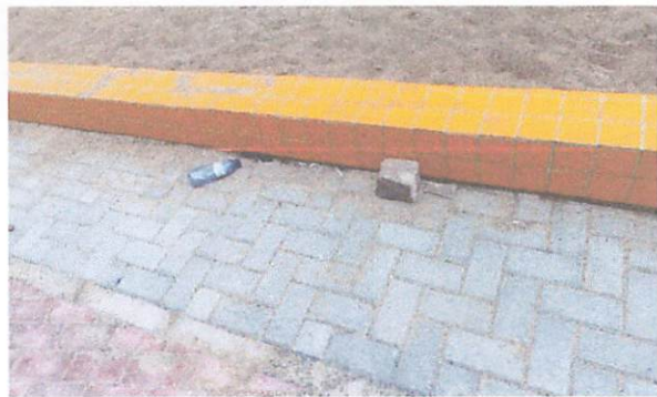
FOTO 3: Revestimento cerâmico amarelo
