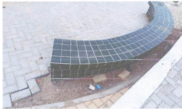
FOTO 4: Revestimento cerâmico verde
