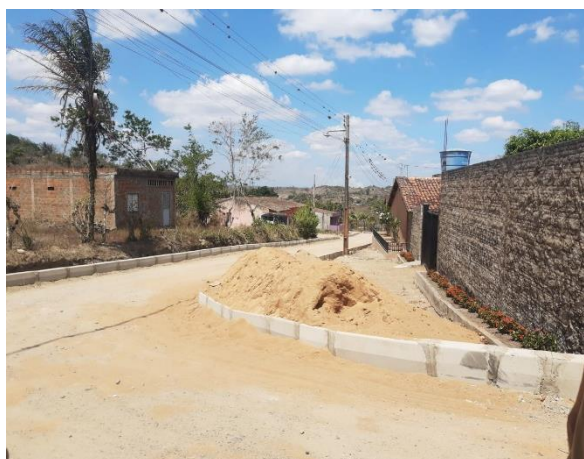
FOTO 5: Instalação de meio fio de concreto – Rua projetada 05
