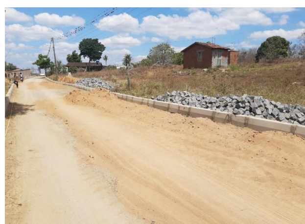
FOTO 6: Instalação de meio fio de concreto – Rua projetada 05
