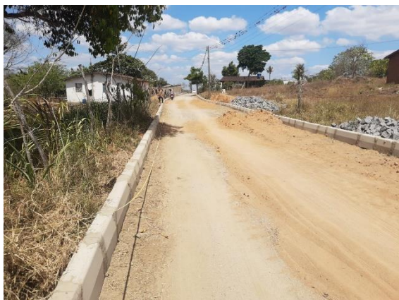
FOTO 1: Instalação de meio fio de concreto – Rua projetada 05
