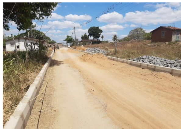
FOTO 2: Instalação de meio fio de concreto – Rua projetada 05
