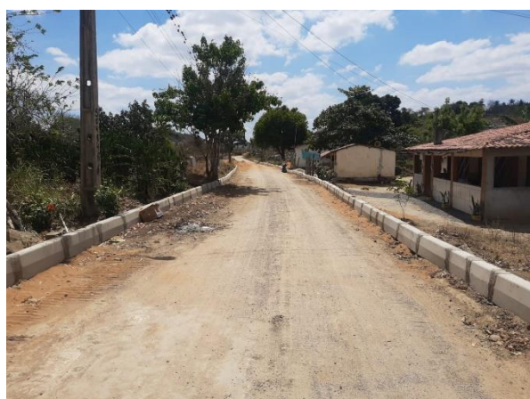
FOTO 3: Instalação de meio fio de concreto – Rua projetada 05
