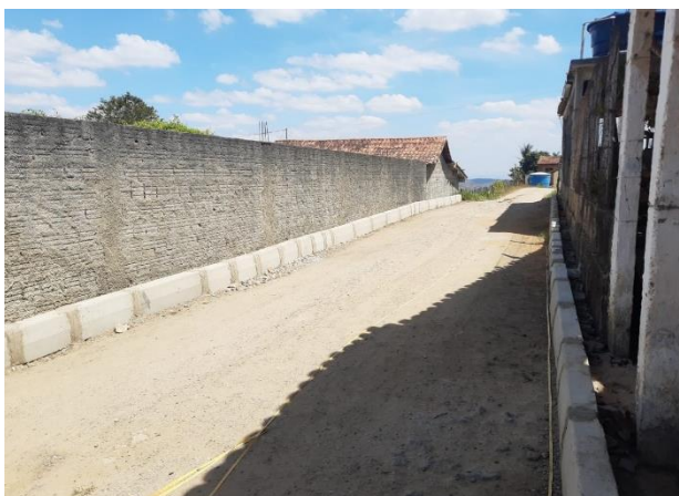
FOTO 4: Instalação de meio fio de concreto – Rua projetada 05
