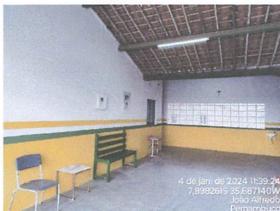
FOTO 8: Pintura da escola municipal Severino Barbosa de Farias
