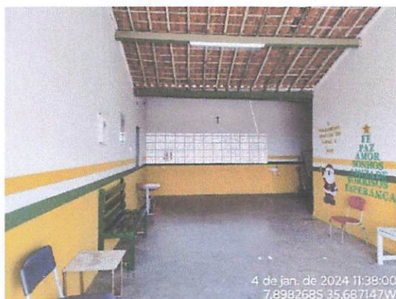
FOTO 10: Pintura da escola municipal Severino Barbosa de Farias
