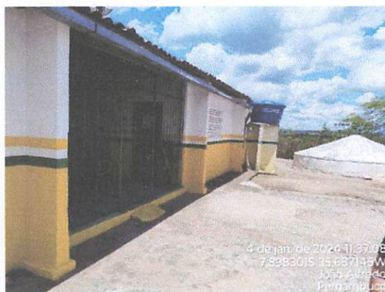
FOTO 12: Pintura da escola municipal Severino Barbosa de Farias
