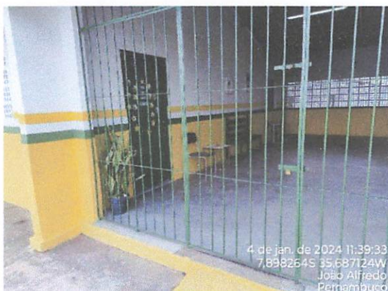
FOTO 7: Pintura da escola municipal Severino Barbosa de Farias
