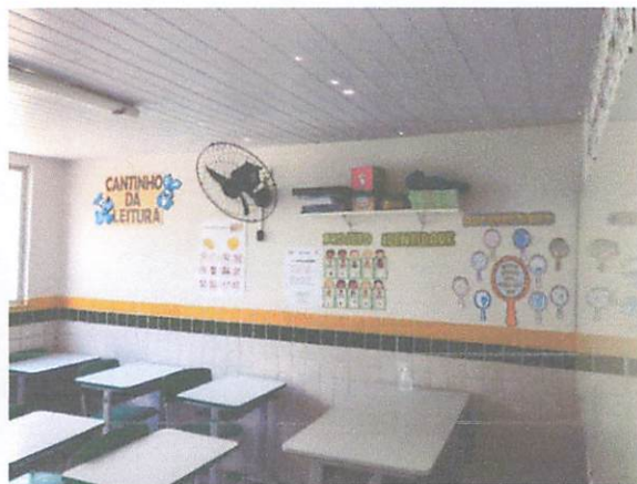
FOTO 32: Pintura da escola municipal Raul Soares
