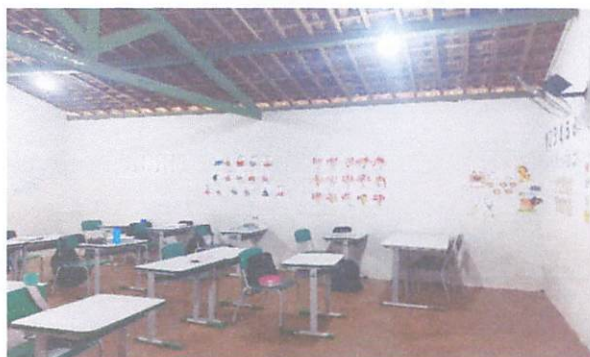
FOTO 9: Pintura da Escola Municipal Heliodoro Gonçalves de Arruda
