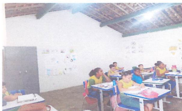
FOTO 12: Pintura da Escola Municipal Heliodoro Gonçalves de Arruda
