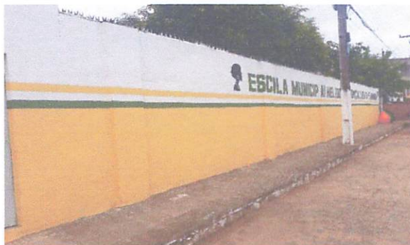
FOTO 7: Pintura da Escola Municipal Heliodoro Gonçalves de Arruda
