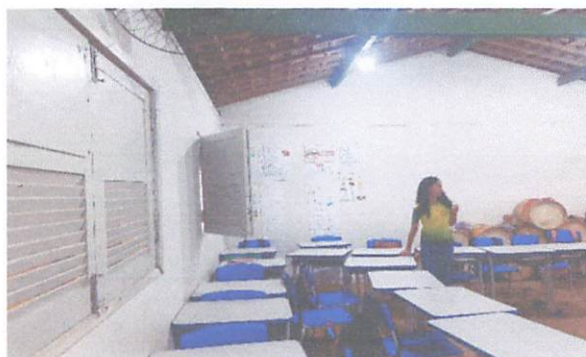
FOTO 10: Pintura da Escola Municipal Heliodoro Gonçalves de Arruda
