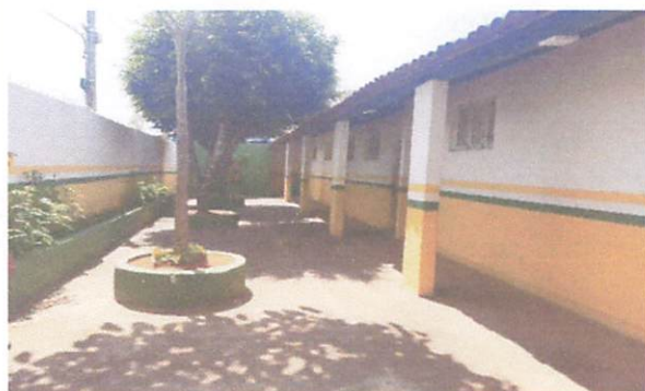
FOTO 11: Pintura da Escola Municipal Heliodoro Gonçalves de Arruda
