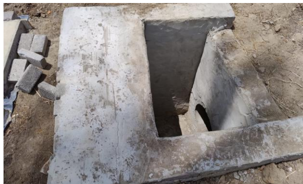
FOTO 26: Drenagem - Caixa (Rua do Catolé)
