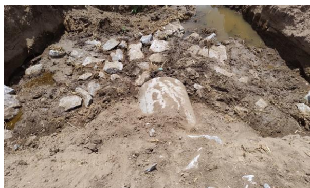
FOTO 28: Drenagem (Rua do Catolé)
