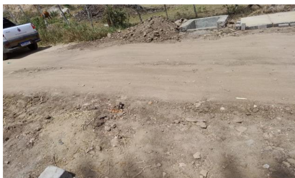
FOTO 27: Drenagem - Caixa (Rua do Catolé)
