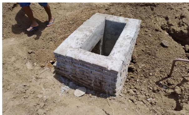
FOTO 18: Caixas de drenagem
