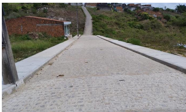
FOTO 21: Pavimentação em paralelepípedos (Rua do Loteamento)
