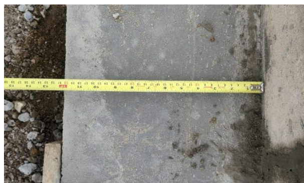
FOTO 4: Sarjeta de concreto
