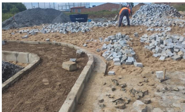
FOTO 11: Aterro das Calçadas (Rua do Loteamento)
