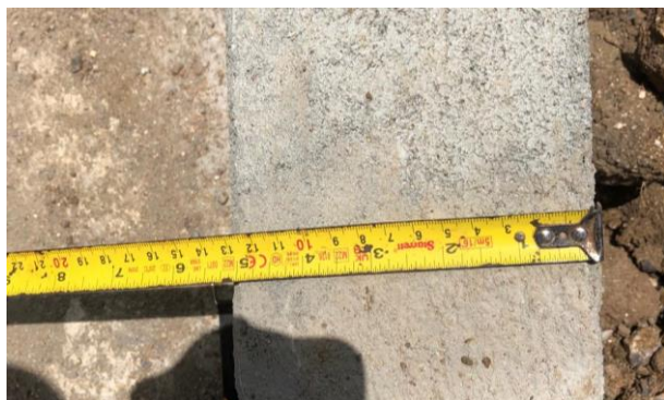
FOTO 5: Meio fio de concreto
