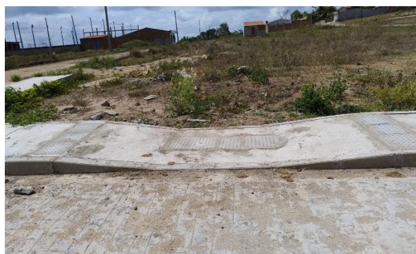
FOTO 22: Rampa de acessibilidade (Rua do Loteamento)
