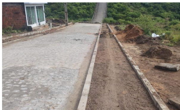
FOTO 12: Aterro das Calçadas (Rua do Loteamento)
