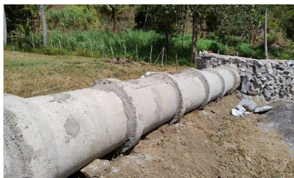
FOTO 16: Drenagem (Rua do Vereador)
