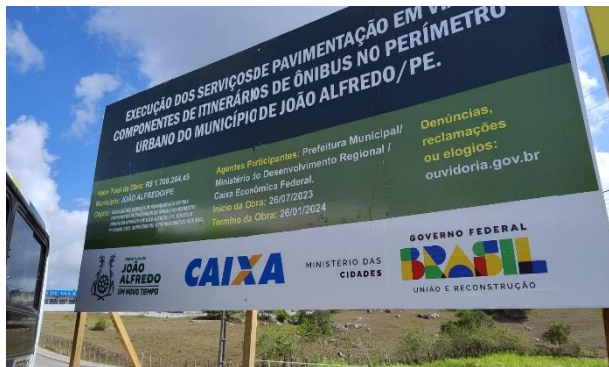
FOTO 1: Placa de obra em chapa aço galvanizado
