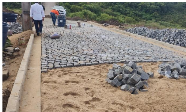
FOTO 6: Pavimentação em paralelepípedos (Rua do Loteamento)
