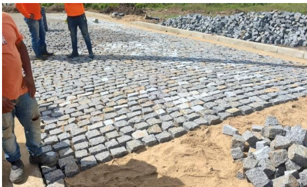
FOTO 7: Pavimentação em paralelepípedos (Rua do Loteamento)
