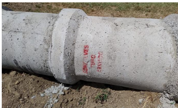
FOTO 17: Drenagem (Rua do Vereador)
