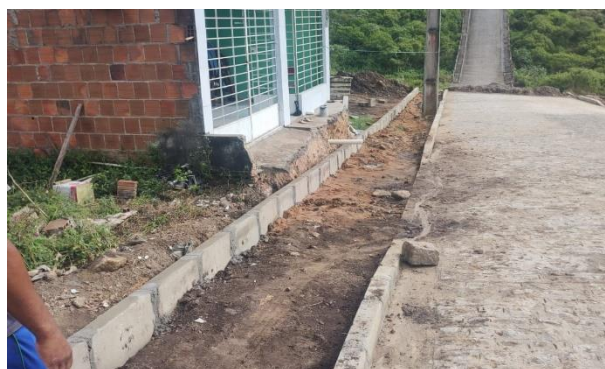
FOTO 10: Meio das Calçadas (Rua do Loteamento)
