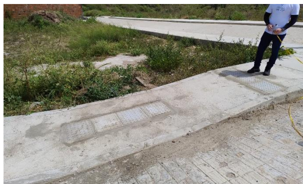
FOTO 24: Rampa de acessibilidade (Rua do Loteamento)
