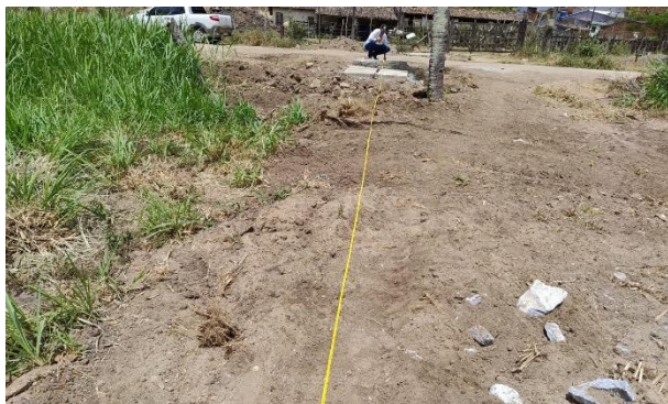
FOTO 25: Drenagem (Rua do Catolé)
