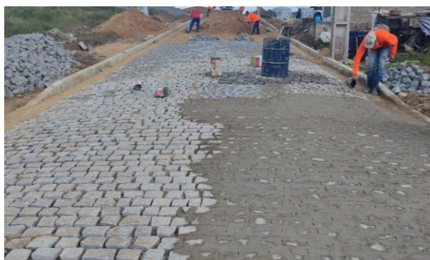
FOTO 9: Pavimentação em paralelepípedos (Rua do Loteamento)
