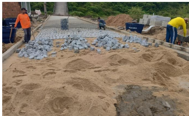
FOTO 8: Pavimentação em paralelepípedos (Rua do Loteamento)
