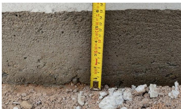
FOTO 3: Sarjeta de concreto
