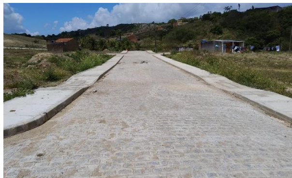
FOTO 20: Pavimentação em paralelepípedos (Rua do Loteamento)
