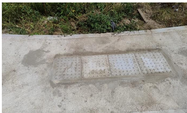
FOTO 23: Rampa de acessibilidade (Rua do Loteamento)
