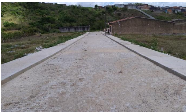
FOTO 19: Pavimentação em paralelepípedos (Rua do Loteamento)
