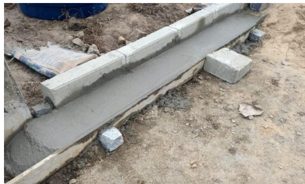
FOTO 2: Meio fio e sarjeta de concreto
