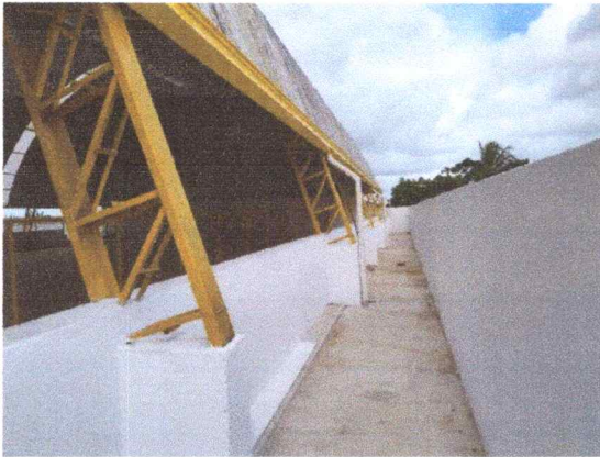
FOTO 3: Concretagem da calçada
