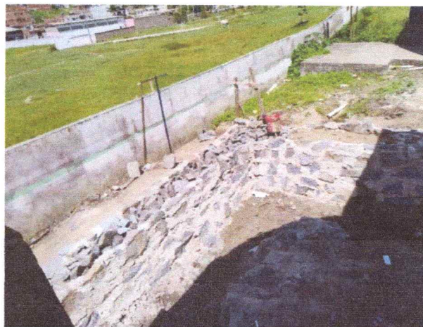
FOTO 6: Alv. de pedra argamassada
