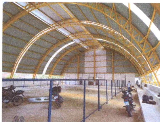
FOTO 2: Alamedado e concretagem do piso
