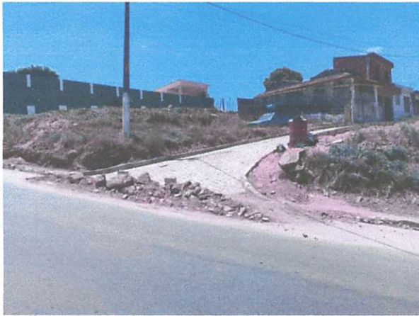
FOTO 1: Pavimentação em paralelepípedos na rua vereador Biu Chico.
