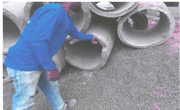
FOTO 14: Execução de drenagem com tubos de 60 cm.
