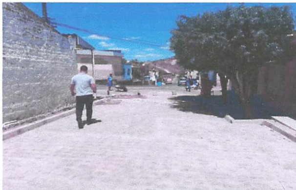
FOTO 5: Pavimentação em paralelepípedos na Avenida Barão de Rio Branco.
