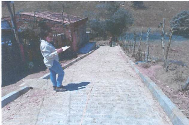
FOTO 3: Pavimentação em paralelepípedos na rua vereador Biu Chico.
