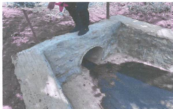
FOTO 17: Execução de ponta de ala.
