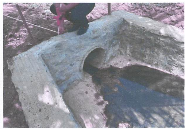
FOTO 16: Execução de ponta de ala.
