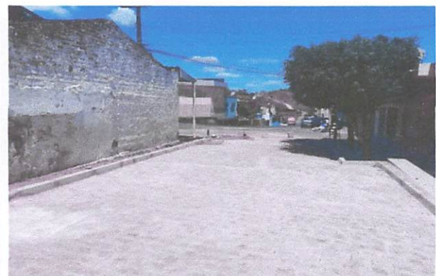
FOTO 6: Pavimentação em paralelepípedos na Avenida Barão de Rio Branco.
