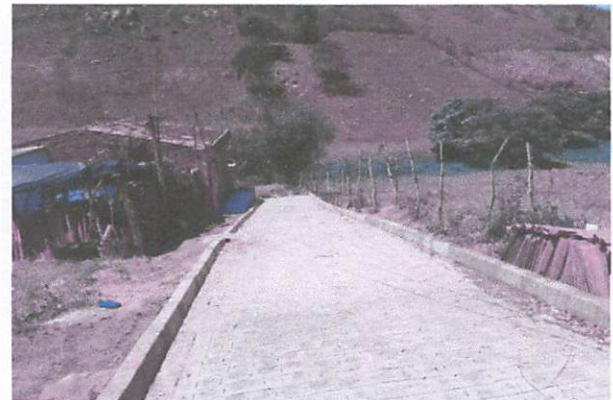
FOTO 4: Pavimentação em paralelepípedos na rua vereador Biu Chico.
