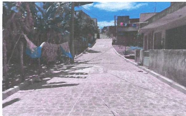
FOTO 10: Pavimentação em paralelepípedos na rua Tiradentes.
