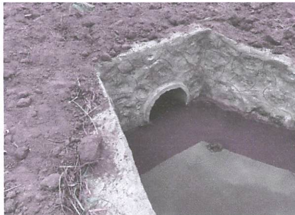
FOTO 15: Execução de ponta de ala.
