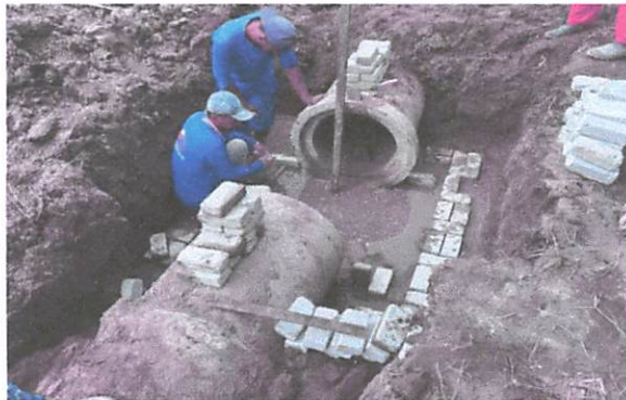
FOTO 13: Execução de drenagem com tubos de 60 cm.
