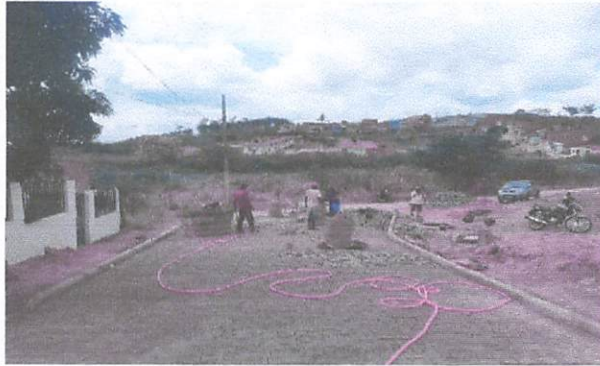
FOTO 7: Pavimentação em paralelepípedos no Sítio Capau.
