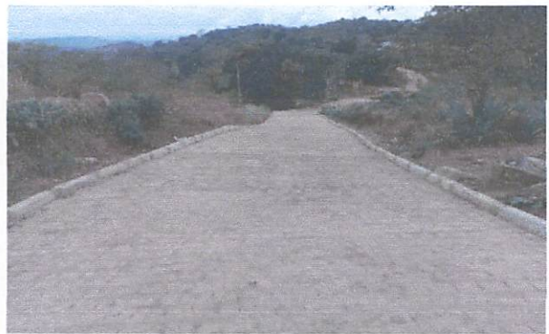
FOTO 16: Pavimentação em paralelepípedos no Sítio Serra Verde.
