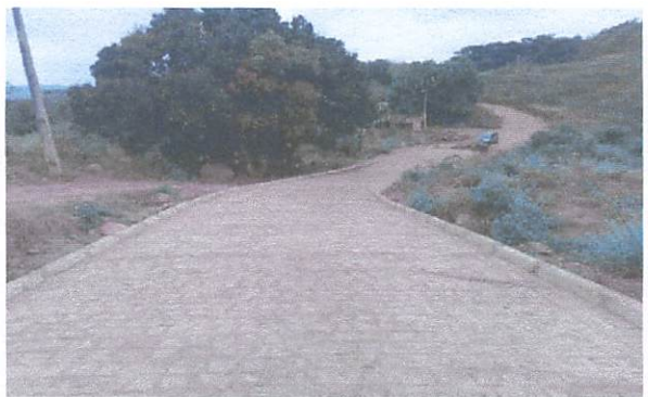
FOTO 17: Pavimentação em paralelepípedos no Sítio Serra Verde.
