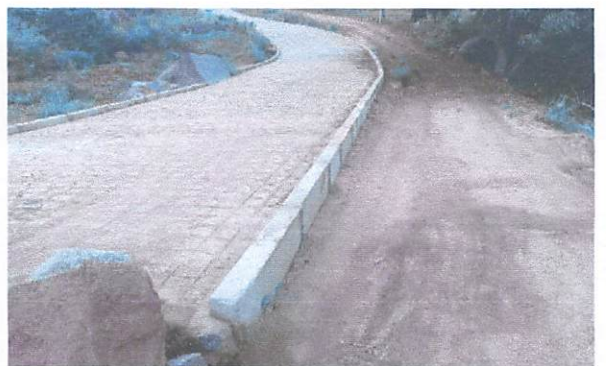
FOTO 18: Pavimentação em paralelepípedos no Sítio Serra Verde.
