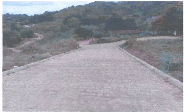
FOTO 14: Pavimentação em paralelepípedos no Sítio Serra Verde.
