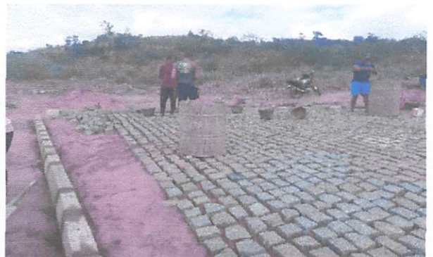
FOTO 10: Pavimentação em paralelepípedos no Sítio Capau.
