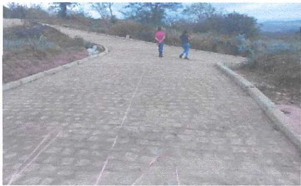
FOTO 15: Pavimentação em paralelepípedos no Sítio Serra Verde.
