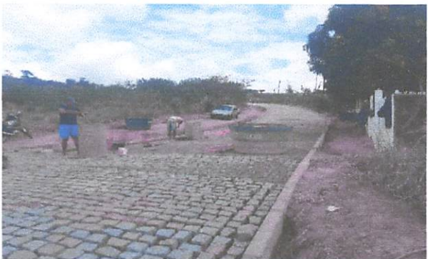
FOTO 11: Pavimentação em paralelepípedos no Sítio Capau.
