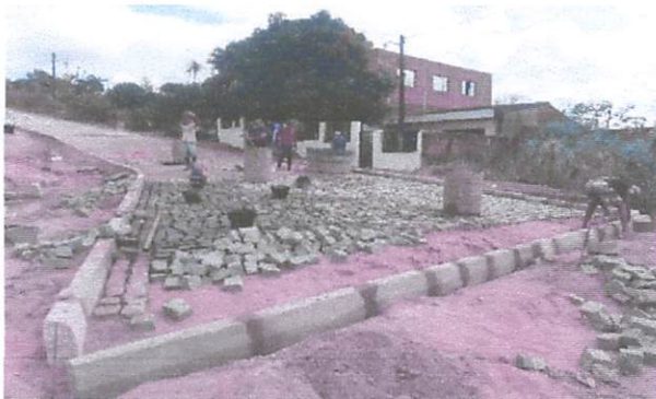
FOTO 9: Pavimentação em paralelepípedos no Sítio Capau.
