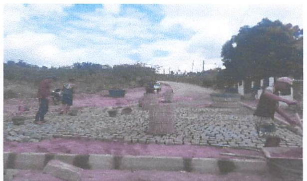
FOTO 12: Pavimentação em paralelepípedos no Sítio Capau.
