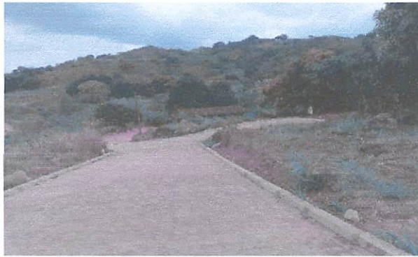
FOTO 13: Pavimentação em paralelepípedos no Sítio Serra Verde.
