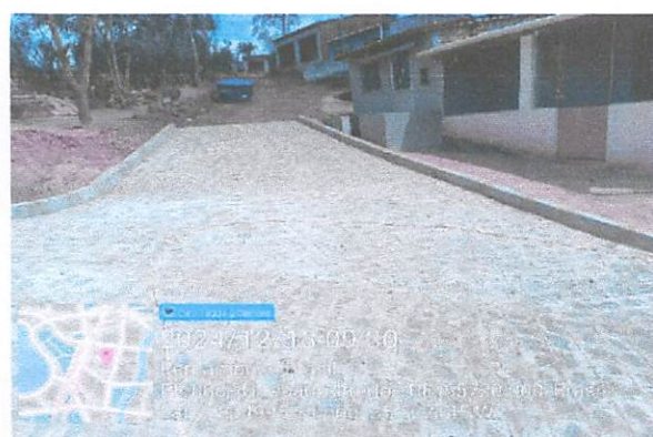
FOTO 6: Pavimentação em paralelepípedos no sitio bela vista/brejinhos.
