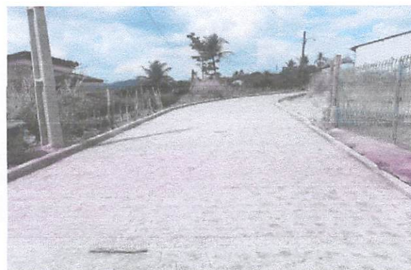
FOTO 9: Pavimentação em paralelepípedos no sitio bela vista/brejinhos.
