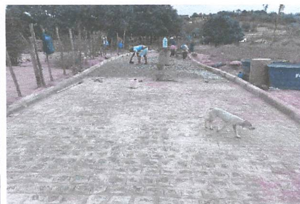
FOTO 11: Pavimentação em paralelepípedos no sitio bela vista/brejinhos.
