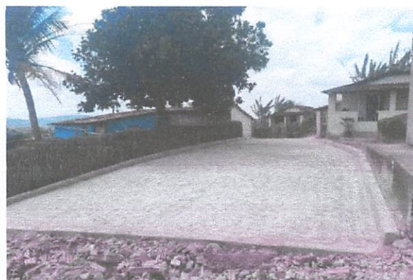
FOTO 5: Pavimentação em paralelepípedos no sitio bela vista/brejinhos.
