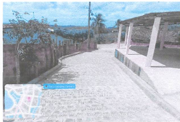
FOTO 8: Pavimentação em paralelepípedos no sitio bela vista/brejinhos.
