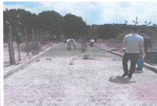
FOTO 12: Pavimentação em paralelepípedos no sitio bela vista/brejinhos.
