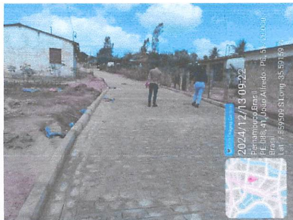
FOTO 1: Pavimentação em paralelepípedos no sitio bela vista/brejinhos.
