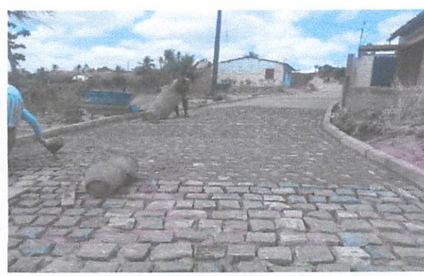
FOTO 10: Pavimentação em paralelepípedos no sitio bela vista/brejinhos.
