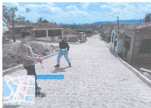
FOTO 4: Pavimentação em paralelepípedos no sitio bela vista/brejinhos.
