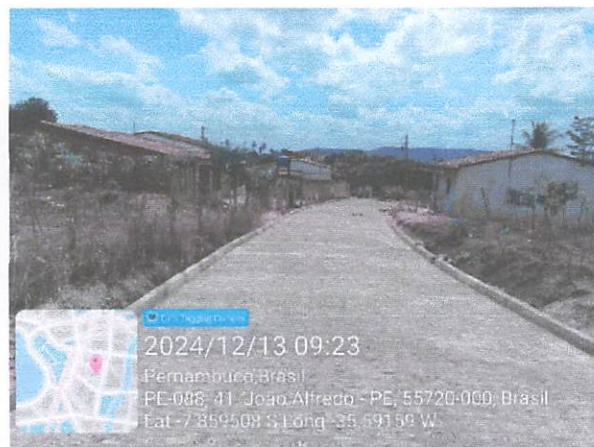
FOTO 2: Pavimentação em paralelepípedos no sitio bela vista/brejinhos.
