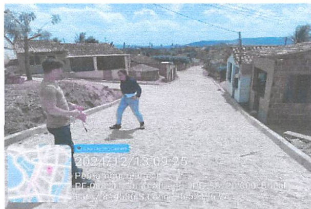
FOTO 7: Pavimentação em paralelepípedos no sitio bela vista/brejinhos.
