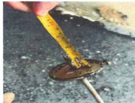
FOTO 12: ESPESSURA DO ASFALTO (BINDER = 3cm + CAPA = 3cm) 6CM
