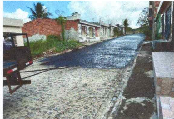
FOTO 2: RUA JOAQUIM LOURE / BAIRRO FREI DAMIÃO / PINTURA DE LIGAÇÃO COM EMULSÃO ASFÁLTICA RR-2C.
