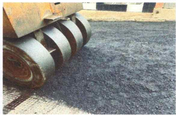
FOTO 8: RUA EVALDO LIMA/ BAIRRO FREI DAMIÃO / APLICAÇÃO DE CONCRETO ASFÁLTICO, CAMADA DE BINDER.
