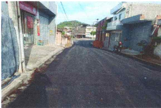
FOTO 9: RUA EVALDO LIMA/ BAIRRO FREI DAMIÃO / APLICAÇÃO DE CONCRETO ASFÁLTICO, CAMADA DE ROLAMENTO.
