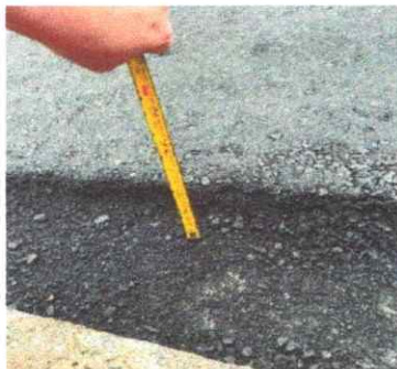
FOTO 11: ESPESSURA DO ASFALTO (BINDER = 3cm + CAPA = 3cm) 6CM
