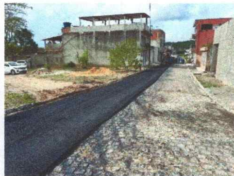
FOTO 4: RUA JOAQUIM LOURE / BAIRRO FREI DAMIÃO / APLICAÇÃO DE CONCRETO ASFÁLTICO, CAMADA DE BINDER.
