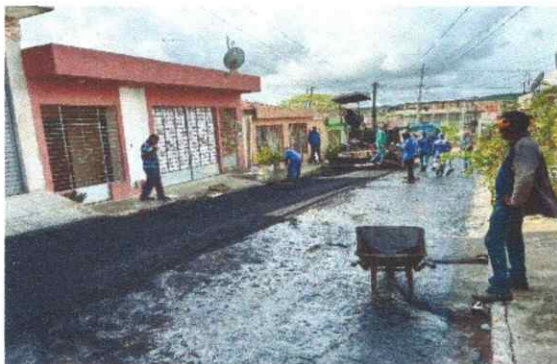
FOTO 3: RUA JOAQUIM LOURE / BAIRRO FREI DAMIÃO / APLICAÇÃO DE CONCRETO ASFÁLTICO, CAMADA DE BINDER.
