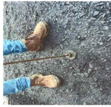
FOTO 10: ESPESSURA DO ASFALTO (BINDER) 3CM
