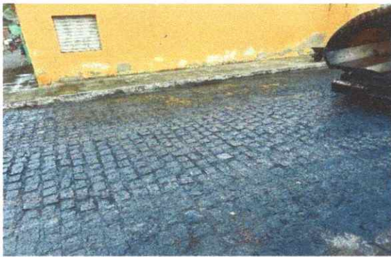
FOTO 7: RUA EVALDO LIMA/ BAIRRO FREI DAMIÃO / PINTURA DE LIGAÇÃO COM EMULSÃO ASFÁLTICA RR-2C.
