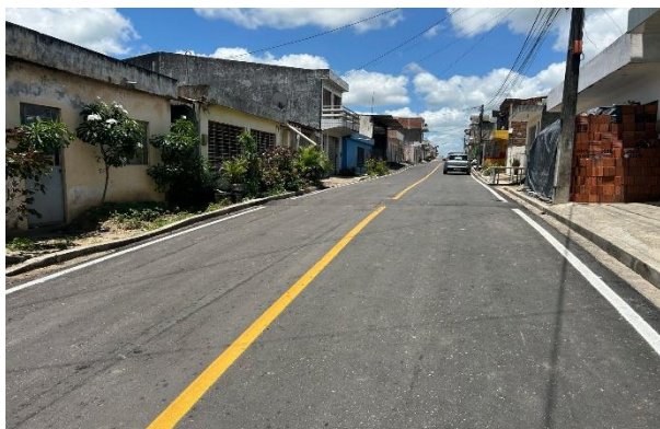
FOTO 3: RUA EDVALDO LIMA / BAIRRO FREI DAMIÃO / SINALIZAÇÃO HORIZONTAL.
