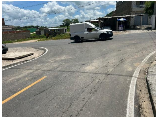
FOTO 2: RUA EDVALDO LIMA / BAIRRO FREI DAMIÃO / SINALIZAÇÃO HORIZONTAL
