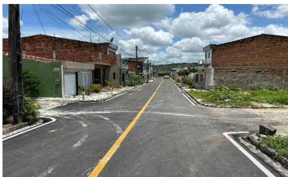
FOTO 11: RUA JOAQUIM LOURE / BAIRRO FREI DAMIÃO / SINALIZAÇÃO HORIZONTAL.
