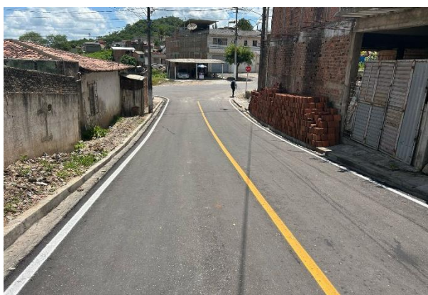
FOTO 5: RUA EDVALDO LIMA / BAIRRO FREI DAMIÃO / SINALIZAÇÃO HORIZONTAL.
