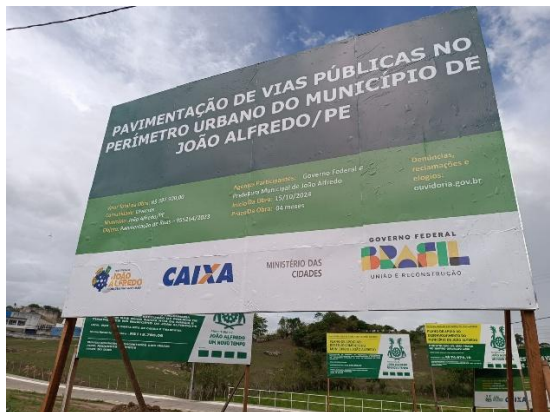
FOTO 1: PLACA DE OBRA EM CHAPA AÇO GALVANIZADO.
