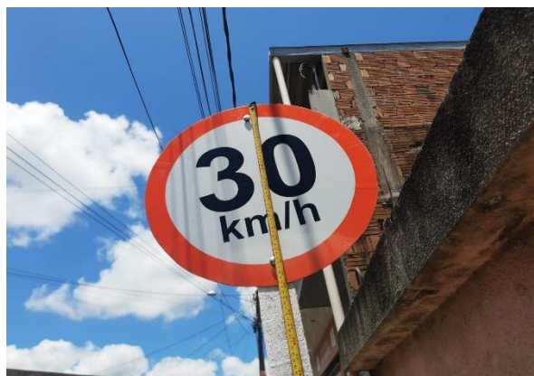
FOTO 6: RUA EDVALDO LIMA / BAIRRO FREI DAMIÃO / SINALIZAÇÃO VERTICAL.
