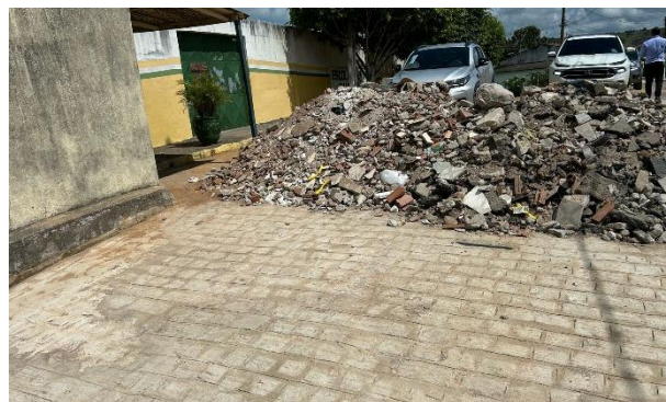
FOTO 12: Rua 02 - Pavimentação em paralelepípedos
