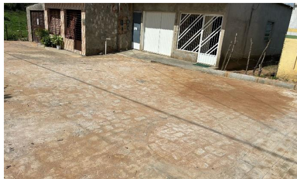
FOTO 8: Rua 02 - Pavimentação em paralelepípedos
