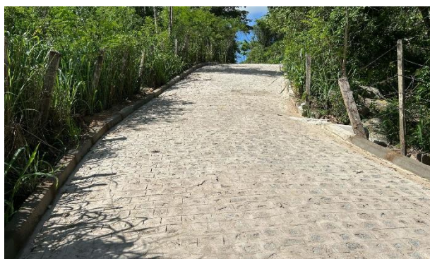
FOTO 3: Rua 02 - Pavimentação em paralelepípedos
