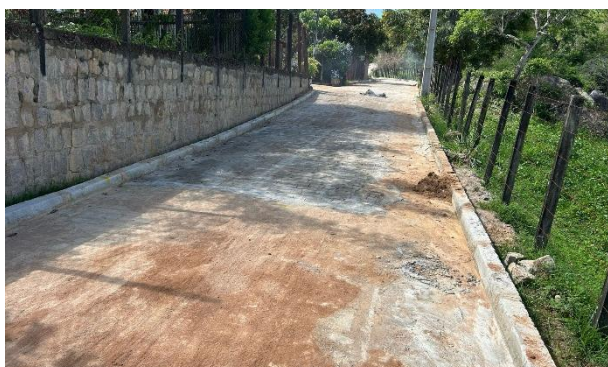
FOTO 9: Rua 02 - Pavimentação em paralelepípedos
