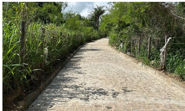
FOTO 2: Rua 02 - Pavimentação em paralelepípedos
