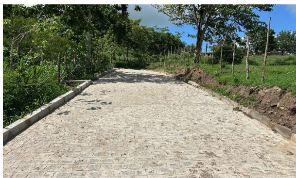
FOTO 5: Rua 02 - Pavimentação em paralelepípedos
