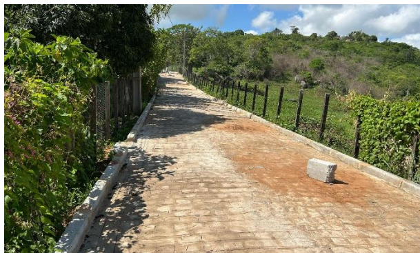
FOTO 1: Rua 02 - Pavimentação em paralelepípedos
