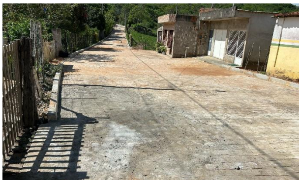
FOTO 11: Rua 02 - Pavimentação em paralelepípedos
