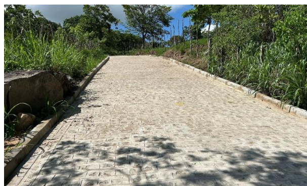
FOTO 6: Rua 02 - Pavimentação em paralelepípedos
