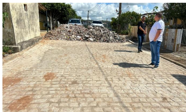
FOTO 10: Rua 02 - Pavimentação em paralelepípedos
