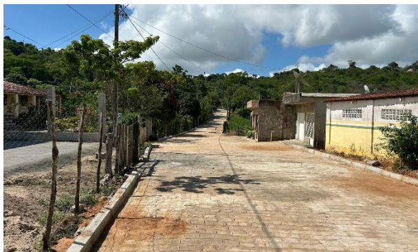
FOTO 7: Rua 02 - Pavimentação em paralelepípedos
