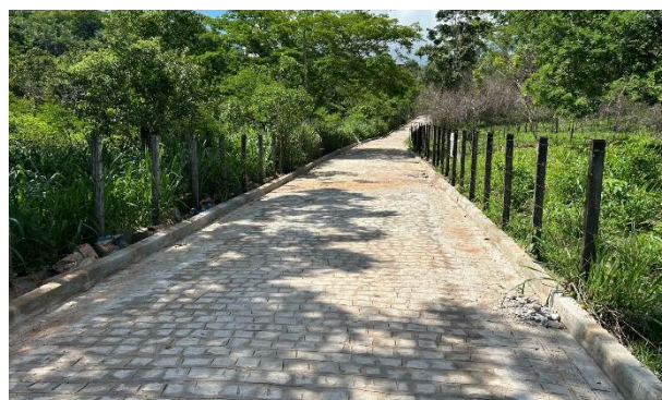
FOTO 4: Rua 02 - Pavimentação em paralelepípedos
