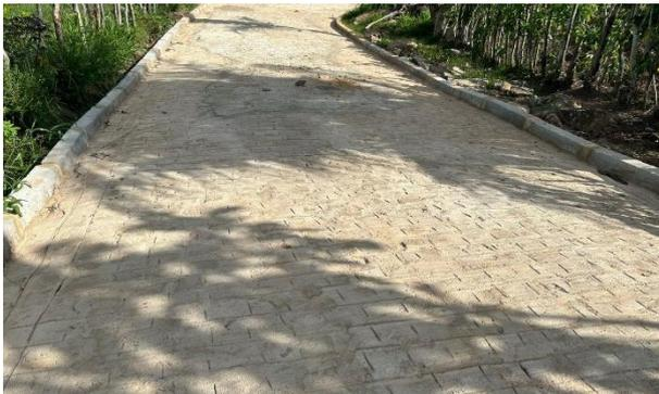
FOTO 3: Rua 02 – Rua 01 – Pavimentação em paralelepíedros, trecho do Muro de contenção
