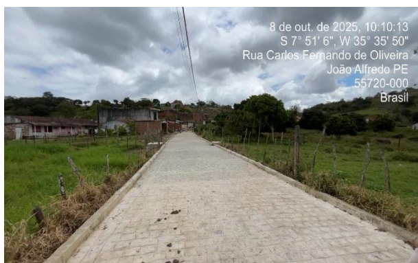
FOTO 3: Rua 2 – Pavimentação em paralelepípedos.
