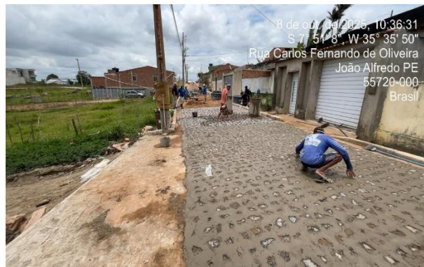
FOTO 2: Rua 2 – Pavimentação em paralelepípedos.
