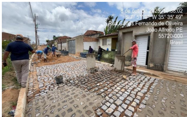
FOTO 1: Rua 2 – Pavimentação em paralelepípedos.
