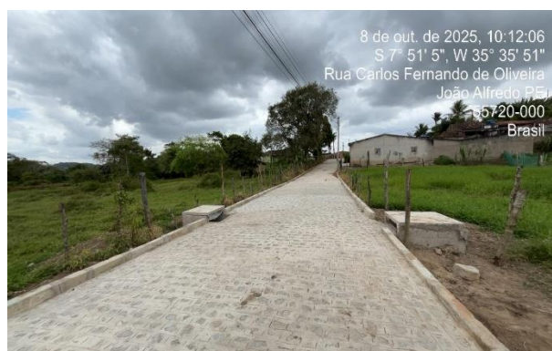
FOTO 4: Rua 2 – Pavimentação em paralelepípedos.
