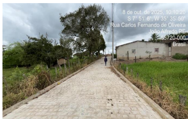
FOTO 4: Rua 2 – Pavimentação em paralelepípedos.
