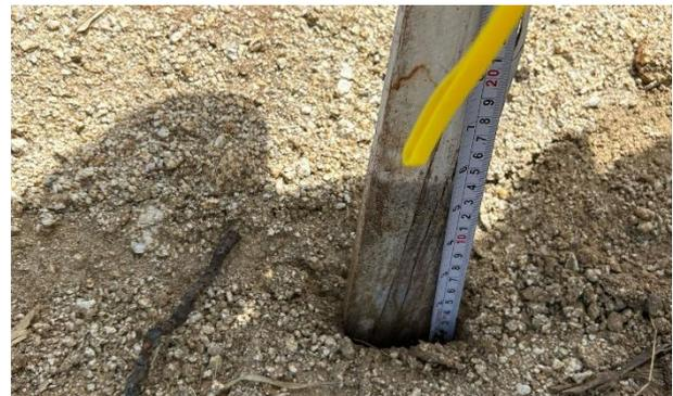
FOTO 12: Espessura do aterro compactado (15cm)
