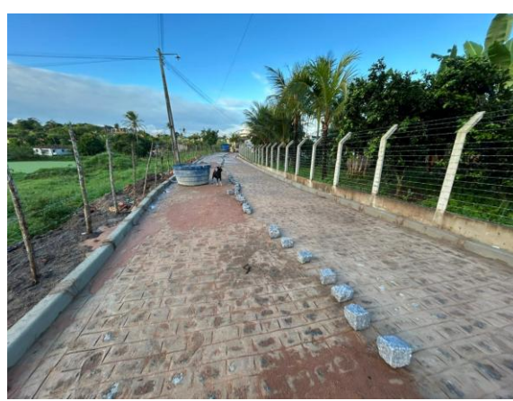
FOTO 2: Pavimentação em paralelepípedos no Sítio Melancia - Rua Projetada 5.
