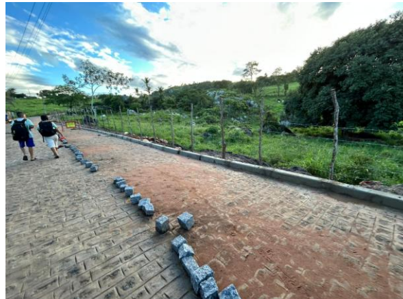
FOTO 4: Pavimentação em paralelepípedos no Sítio Melancia - Rua Projetada 5.
