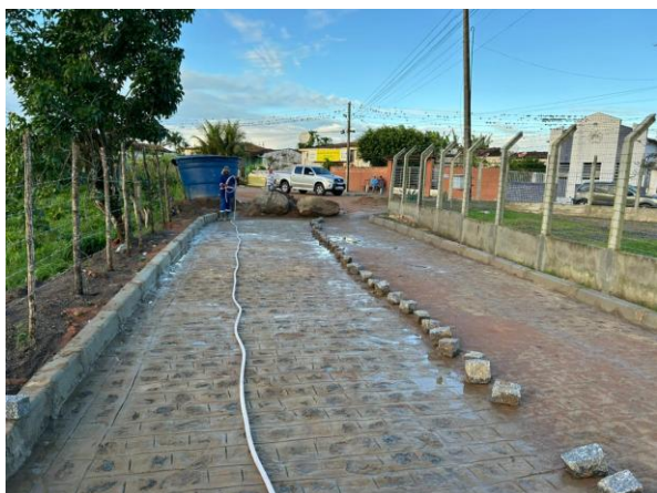
FOTO 5: Pavimentação em paralelepípedos no Sítio Melancia - Rua Projetada 5.
