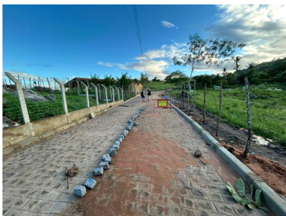
FOTO 3: Pavimentação em paralelepípedos no Sítio Melancia - Rua Projetada 5.
