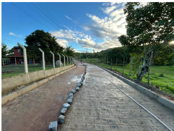
FOTO 1: Pavimentação em paralelepípedos no Sítio Melancia - Rua Projetada 5.
