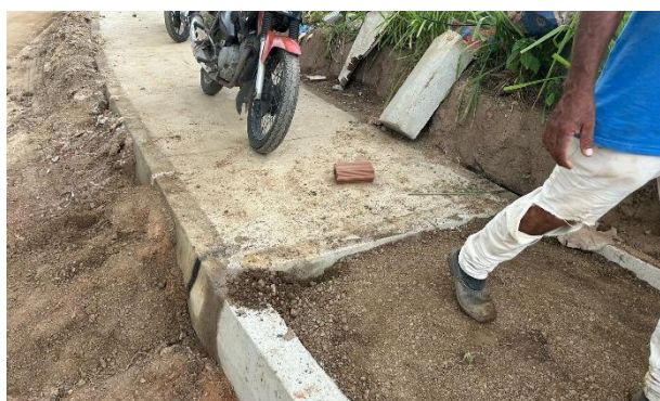
FOTO 5: Rua do Catolé (Calçadas - concreto 6cm)
