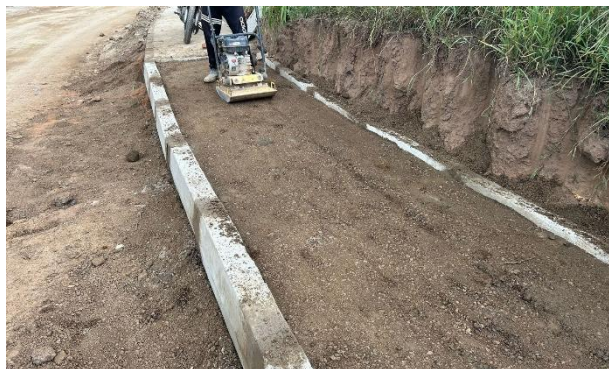
FOTO 1: Rua do Catolé (Meio fio e Aterro)
