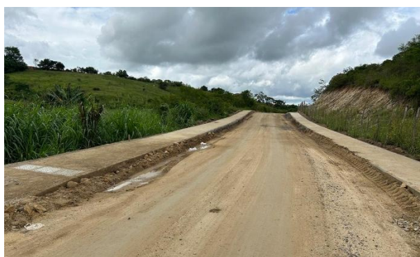
FOTO 6: Rua do Catolé (Calçadas LD/LE)
