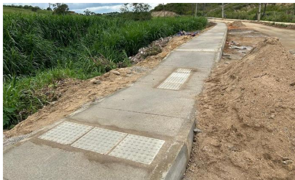
FOTO 2: Rua do Catolé (Rampa - Piso Tátil)
