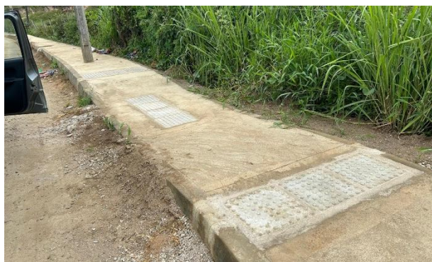
FOTO 3: Rua do Catolé (Rampa - Piso Tátil)
