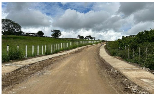
FOTO 4: Rua do Catolé (Calçadas LD/LE)
