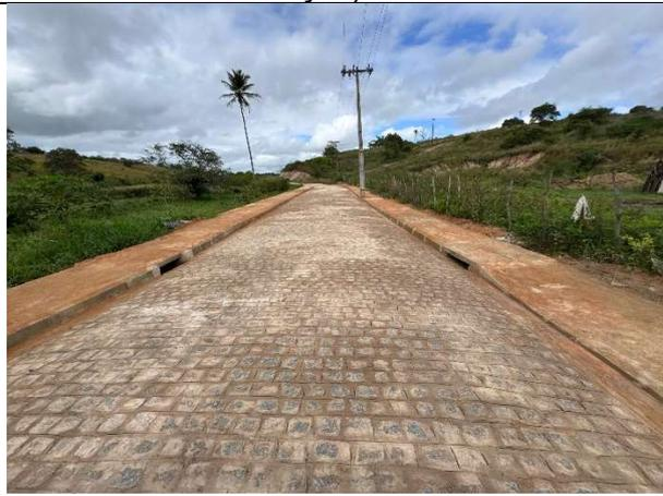
FOTO 8: Rua do Catolé (Calçada LD e LE, Meio Fio, Rebaixo, Drenagem, Pavimentação)
