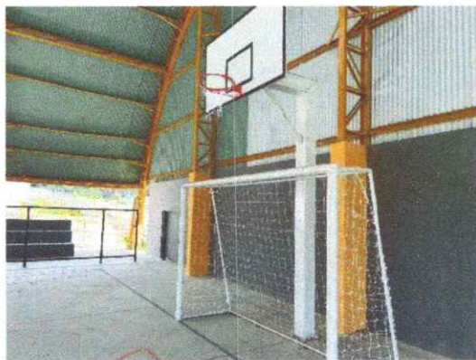
FOTO 7: piso e equipamentos
