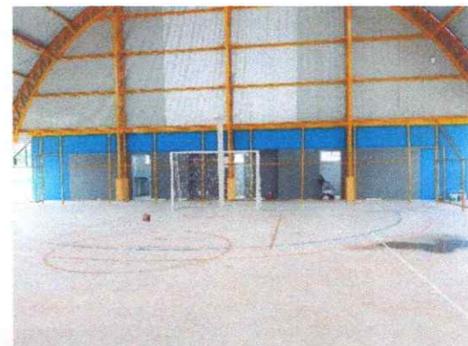
FOTO 6: piso e equipamentos
