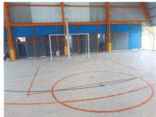
FOTO 24: Pintura interna, piso e paredes
