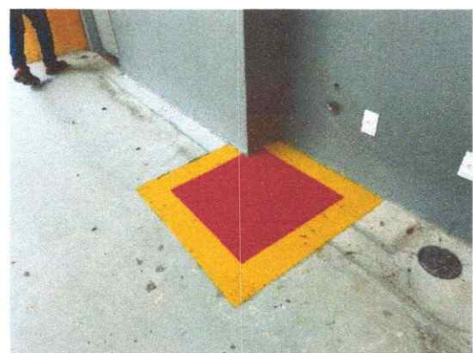
FOTO 15: sinalização piso extintores
