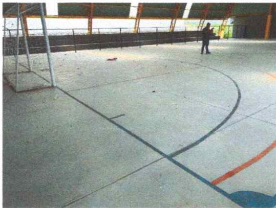
FOTO 7: piso e equipamentos
