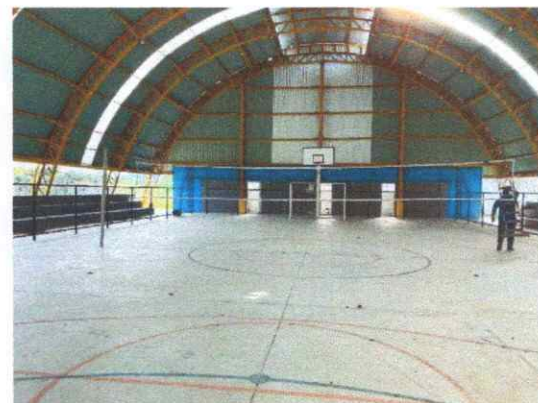
FOTO 6: piso e equipamentos
