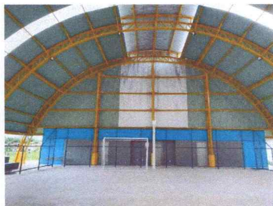
FOTO 24: Pintura interna, piso e paredes
