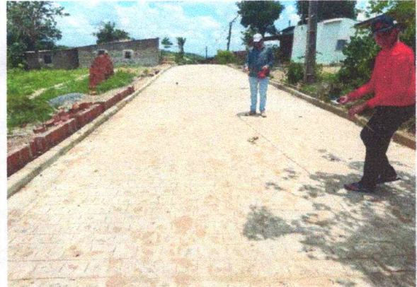
FOTO 2: Pavimentação em paralelepípedos no Sítio Melancia/Rua projetada.
