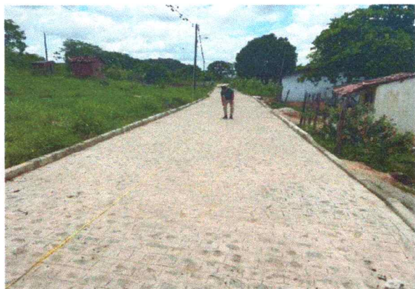
FOTO 3: Pavimentação em paralelepípedos no Sítio Melancia/Rua projetada.
