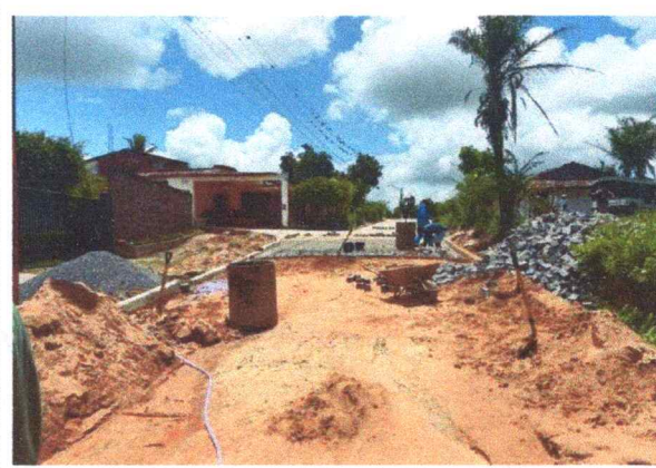
FOTO 6: Construção de muro de arrimo no Sítio Melancia/Rua projetada.
