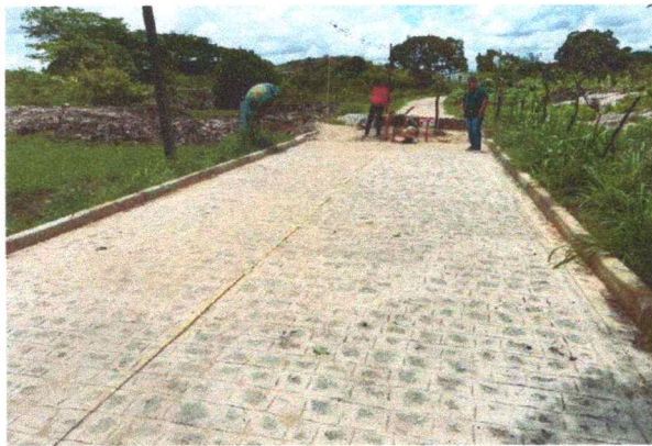
FOTO 1: Pavimentação em paralelepípedos no Sítio Melancia/Rua projetada.
