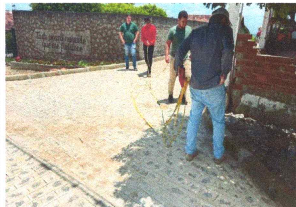
FOTO 4: Construção de muro de arrimo no Sítio Melancia/Rua projetada.
