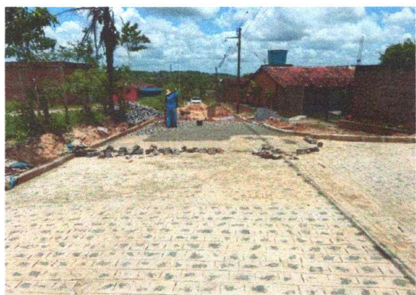
FOTO 5: Construção de muro de arrimo no Sítio Melancia/Rua projetada.
